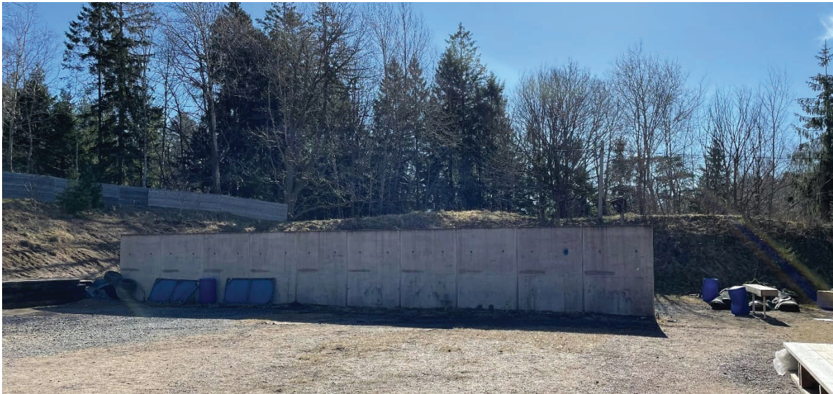
Figur 5. Foto av betongväggen längs skjutbanan Fältet.
