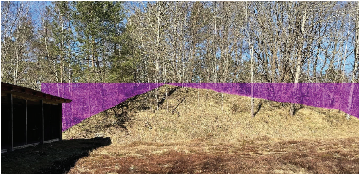
Figur 8. Det lila området markerar föreslagen justering av vallen så att ett ca 50 m långt avsnitt får markhöjd ca 98 m.ö.h.
