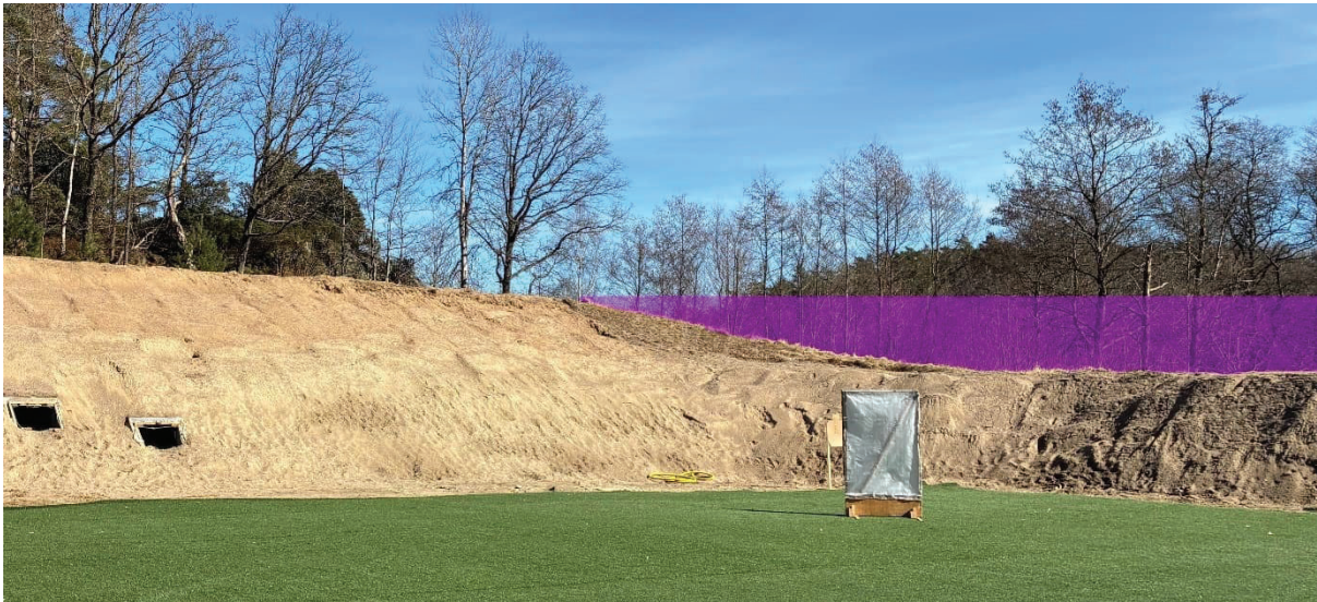
Figur 11. Det lila området markerar föreslagen justering av vällen så att ett ca 50 m långt avsnitt får markhöjd ca 78 m.ö.h.
