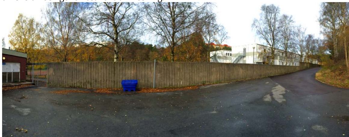
Figur 2 Betongmur vid infart
