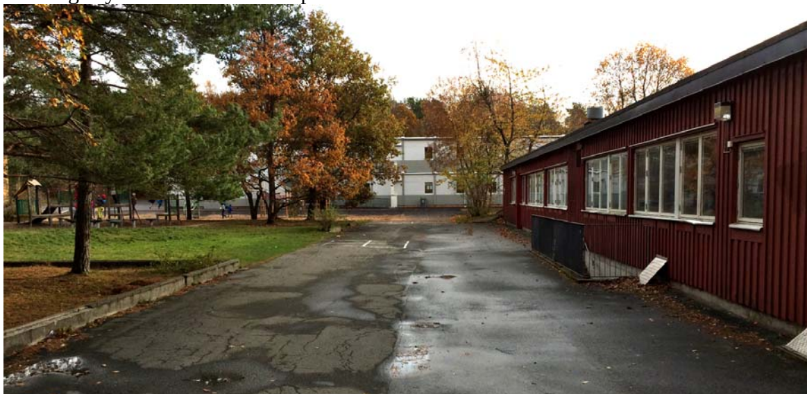
Figur 4 Äldre paviljong till höger, nyare rakt fram och uppvuxna träd till vänster
