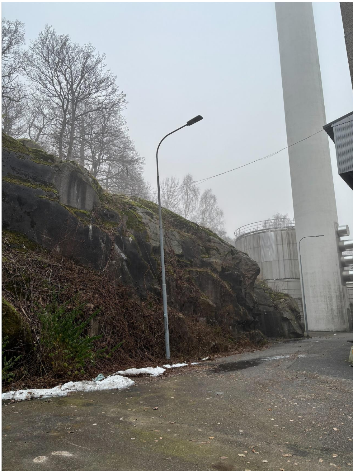
Bild 8: Slänt västerut bakom befintlig panncentral där man ser den schaktade bergslänten.
