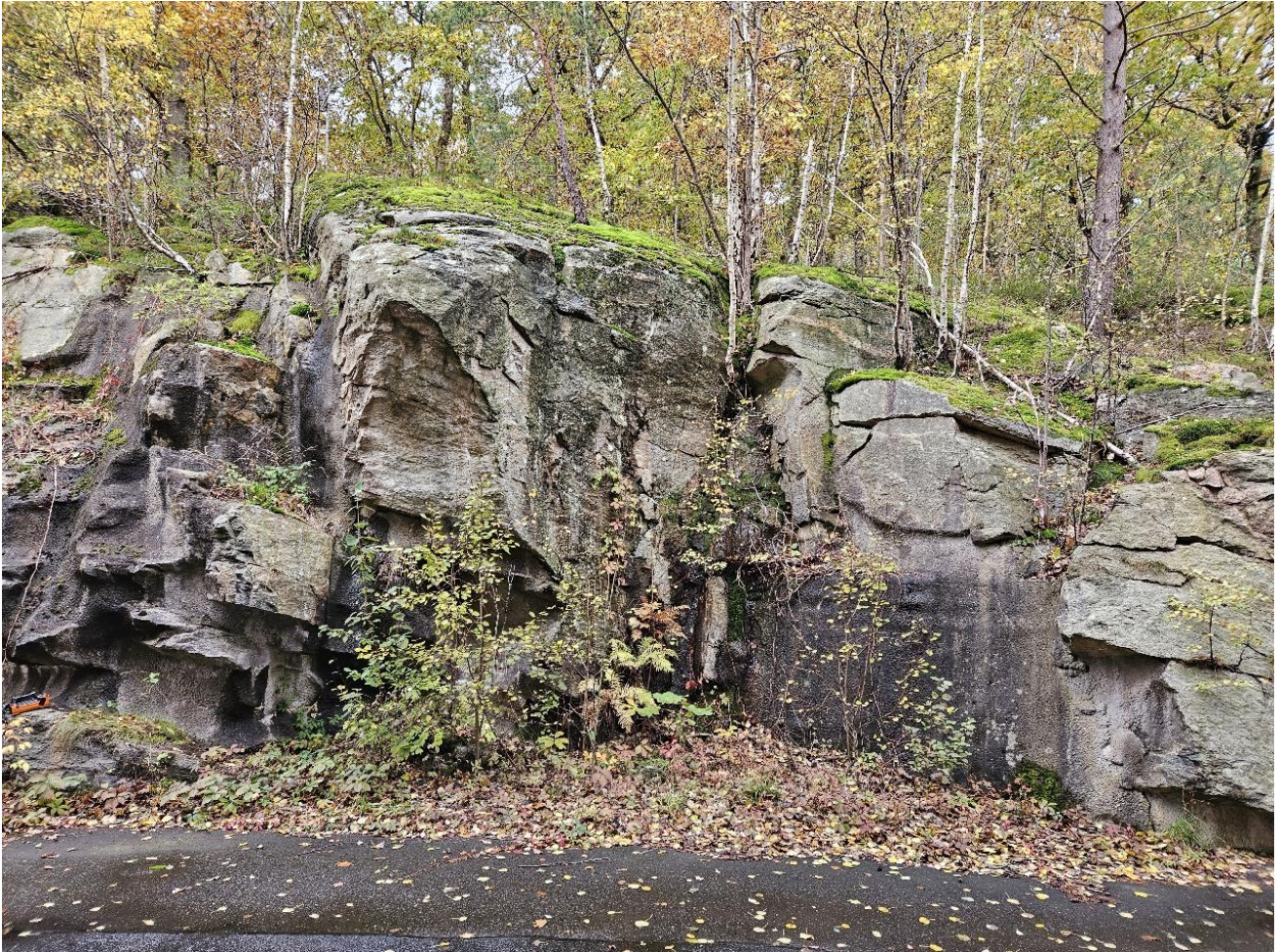
Figur 5 Fotografi av vegetation som har fått fäste i sprickor i den befintliga slänten och som kan komma att påverka bergskvaliteten i framtiden. Se skada 5 i Figur 7.
