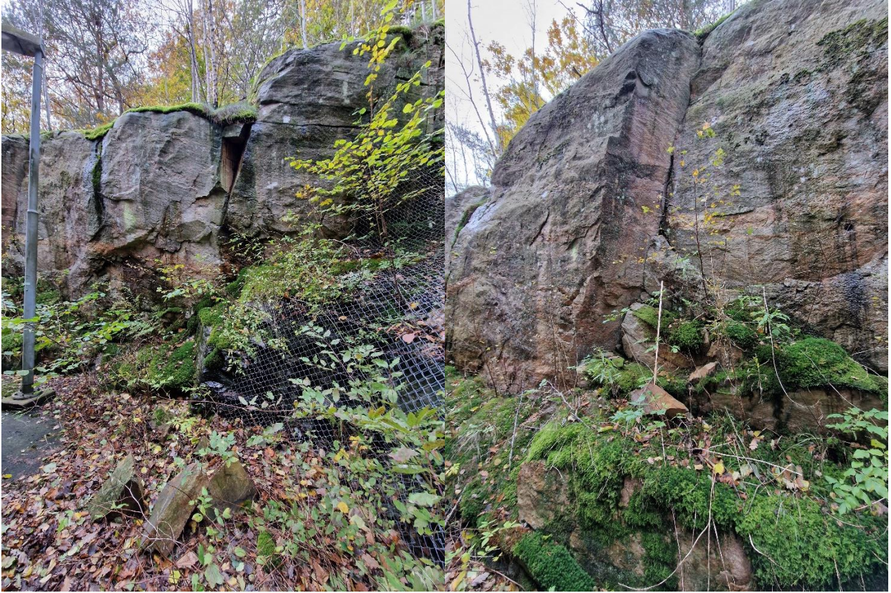
Figur 3 Fotografier av blockutfall i den befintliga släntens norra del. Utfallet till vänster är kilformat. Se skada 2 och 3 i Figur 7.
