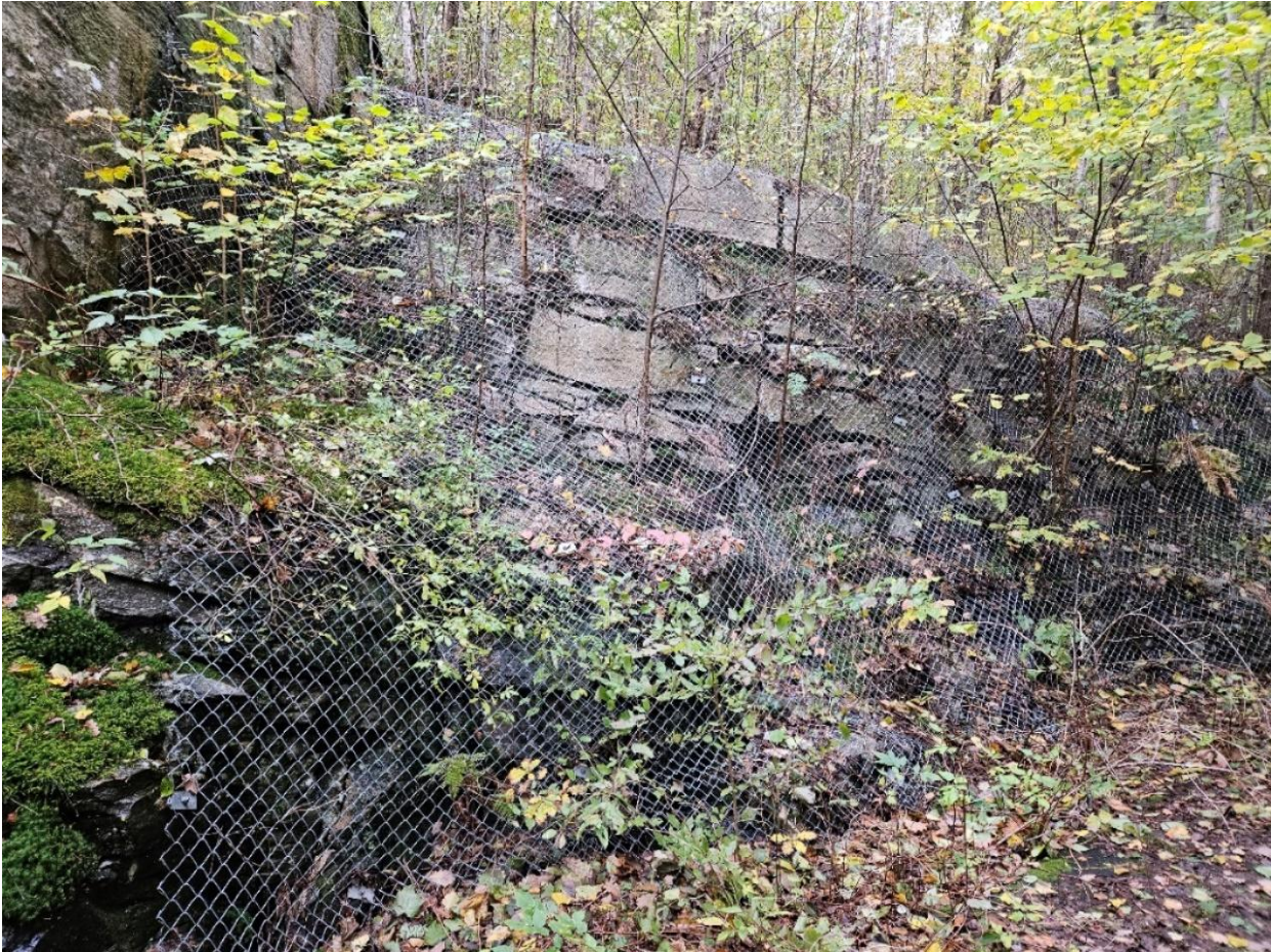
Figur 2 Fotografi av Gunnebo-bergnät i norra delen av den befintliga slänten. Vegetation bakom nätet kan komma att påverka bergskvailteteten och nätets funktion i framtiden. Se skada 1 i Figur 7.
