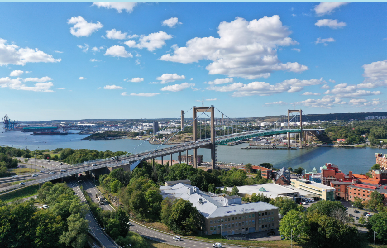
Bild 33. Området sett från sydöst med Älvsborgsbron och Klippan
