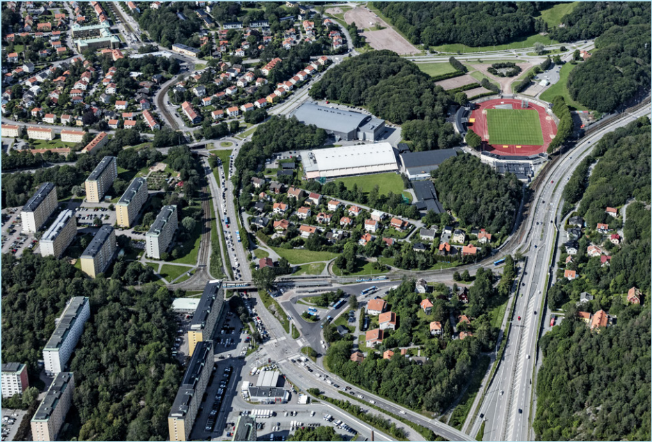
Bild 41. Området sett från söder med Slottsskogsvalen i bakgrunden
