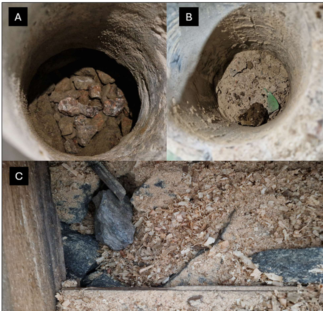
Figur 12. Bilder över A) 25NC04; B) 25NC02; C) 25NC11. © Norconsult. Inga prover uttogs vid ovan provpunkter på grund av otillräckligt med finmaterial.
