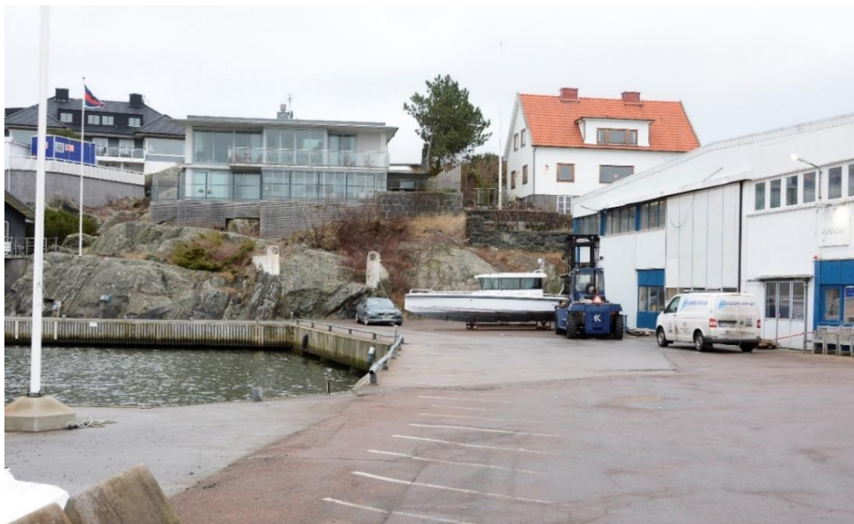
Figur 12. Befintlig bebyggelse inom planområdet till höger i bild med angränsande villabebyggelse i bakgrunden.
