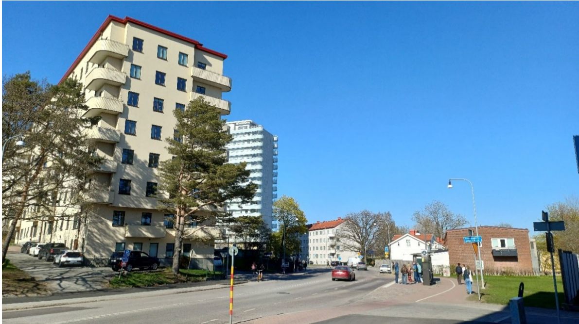
Stadsmiljön norr om Eklandagatan. I förgrunden lamellhus i riksintresset. Till höger befintlig byggnad inom planområdet.
