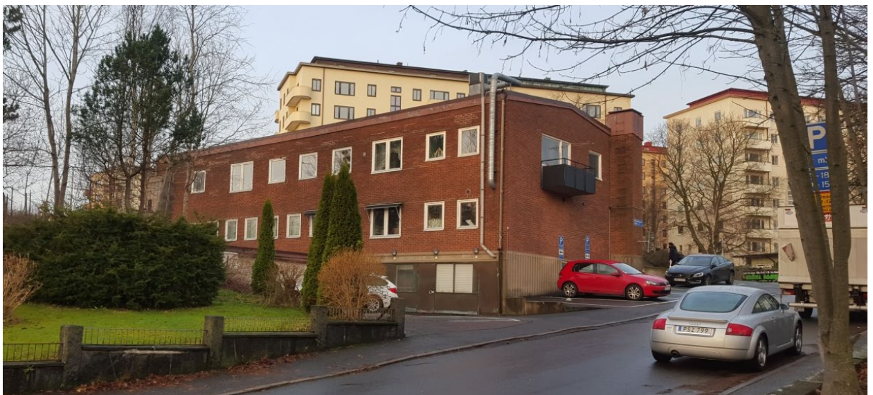
Befintlig byggnad sedd från sydost, från Bergsprängaregatan. De funktionalistiska lamellbyggnaderna inom riksintresset för Övre Johanneberg syns i bakgrunden.
