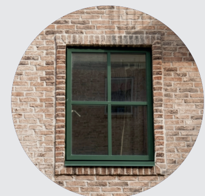
Fönsteromfattningar i tegel
