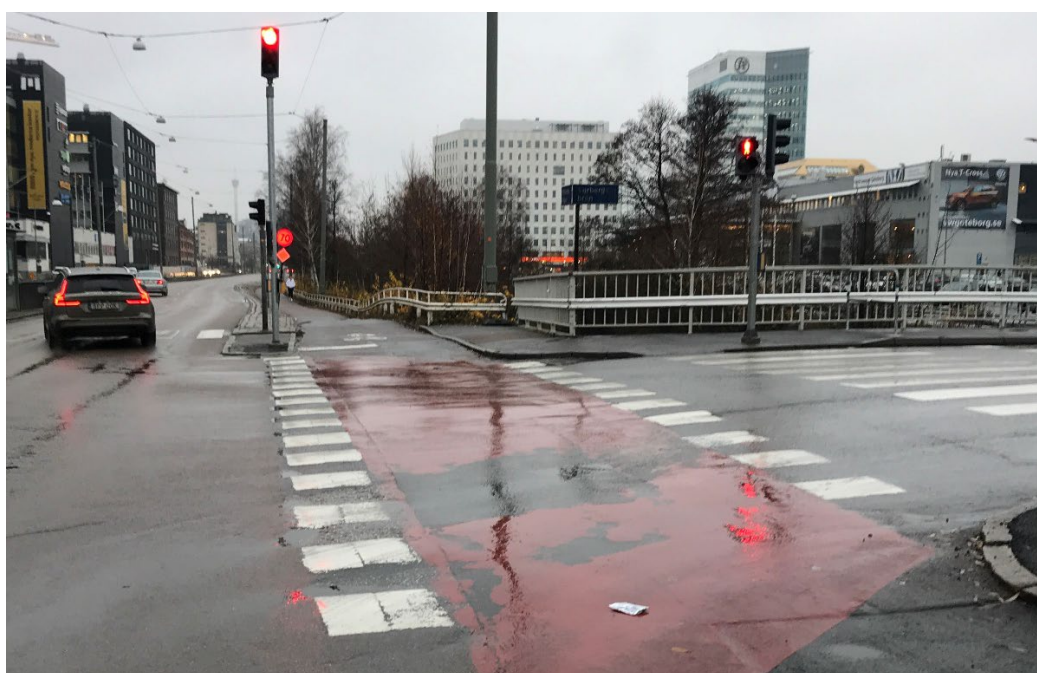
Figur 6 Övergångsställe vid Varbergsbron, vy norrut (Foto: COWI AB)
