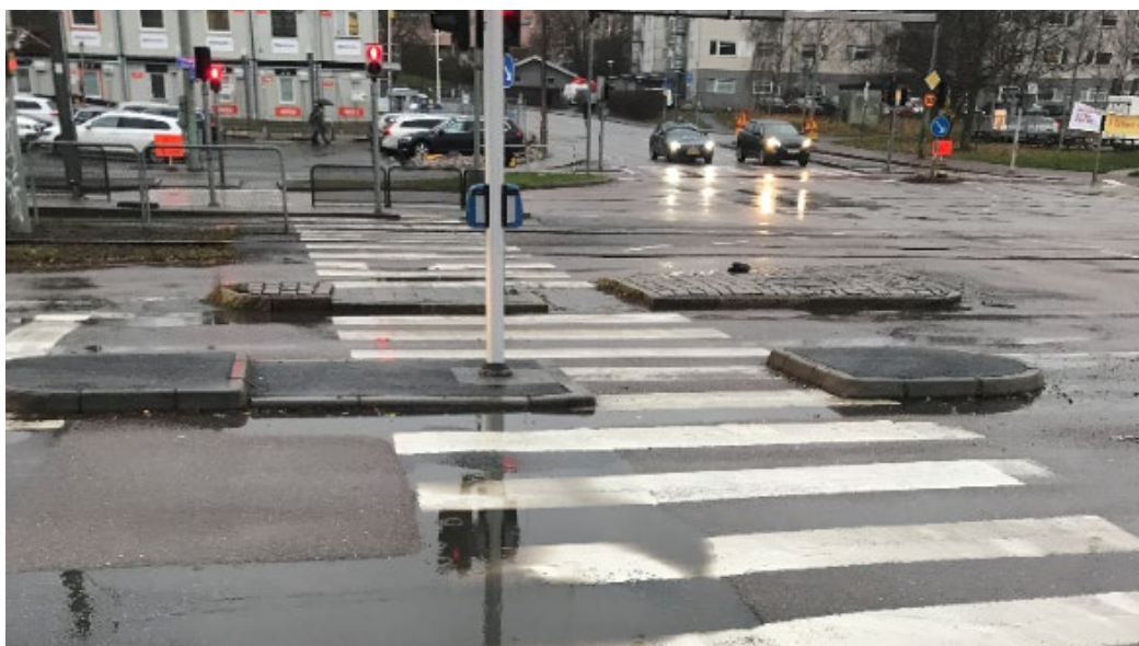
Figur 5 Övergångställen vid korsningen Mölndalsvägen/Sankt Sigfridsgatan/Fredriksdalsgatan, vy västerut (Foto: COWI AB)
