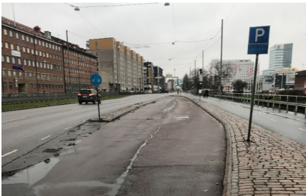
Figur 19 Det kombinerade hållplatsen Lana, hållplatsläge E, och 10-minutersparkeringen, vy norrut (Foto: COWI AB)
