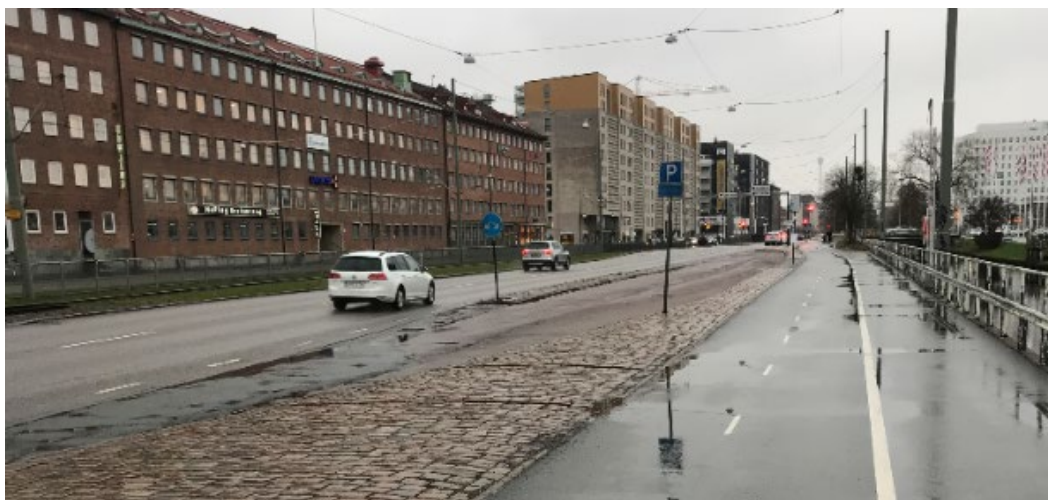
Figur 4 Gång- och cykelbana mellan kommungränsen och Varbergsbron, vy norrut (Foto: COWI AB)
