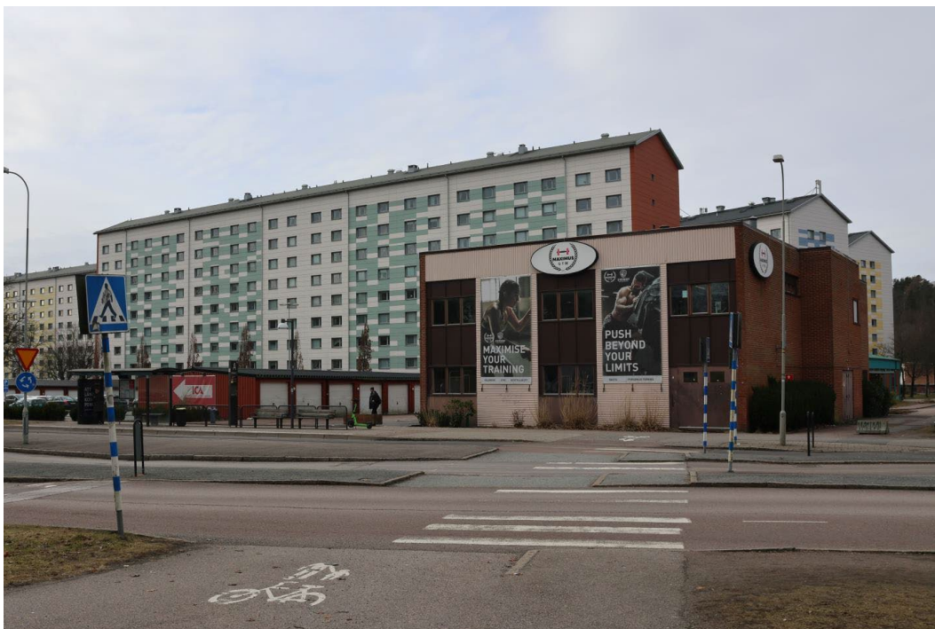
Figur 17 - Foto på före detta panncentralen. (Lindholm Restaurering AB, 2025)
