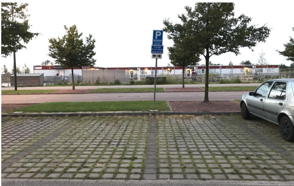
Figur 4-7. Exempel på en genomsläpplig beläggning i form av gräsarmering på en parkeringsplats. Källa: Structor
