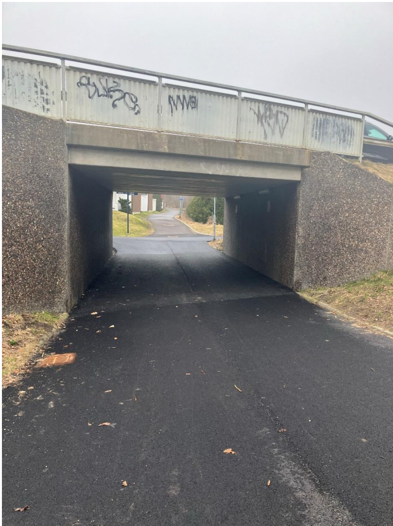
Figur 6 Gång- och cykeltunnel
