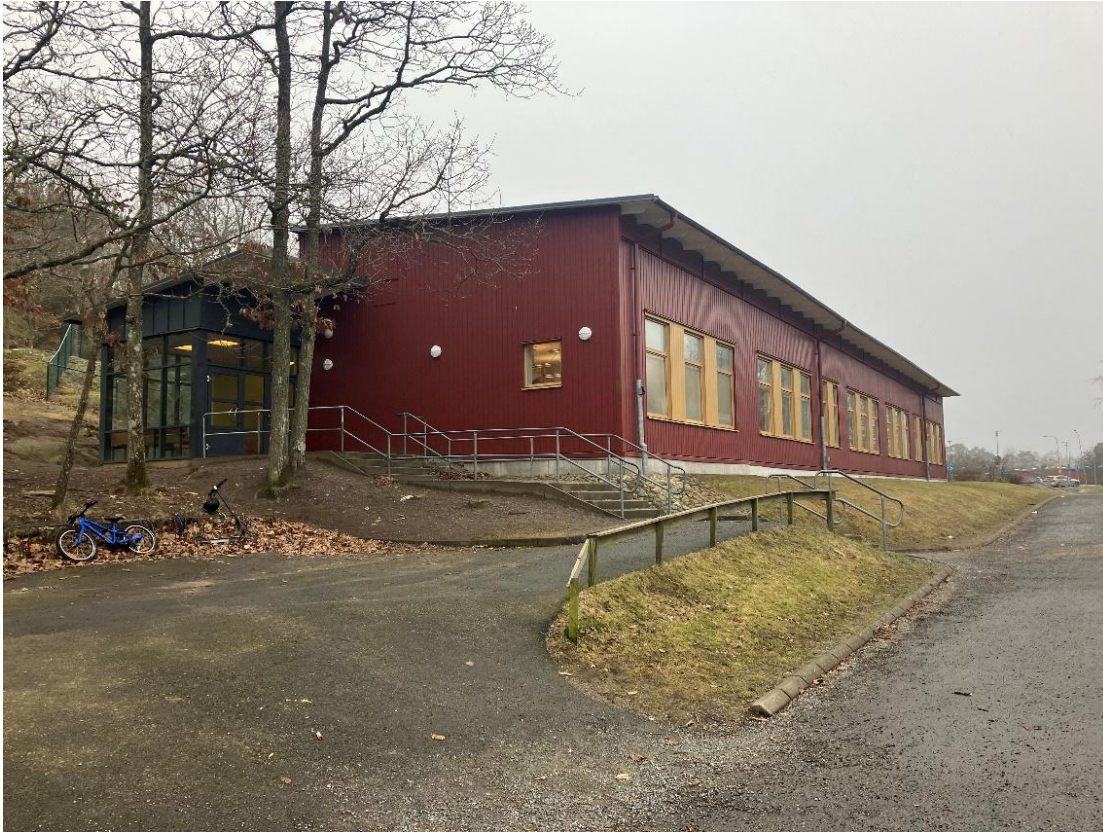
Figur 7 Skolbyggnad som kommer att rivas. Lindåsstråket går till höger om byggnaden.
