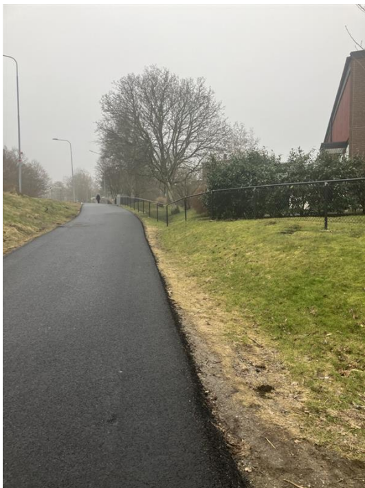
Figur 8. Gång- och cykelväg väster om Södra Särövägen.
