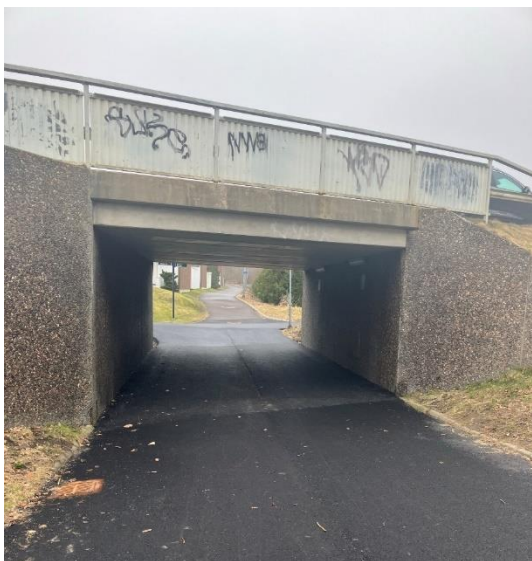
Figur 6. Gång- och cykeltunnel under Södra Särövägen, som del av Lindåsstråket.
