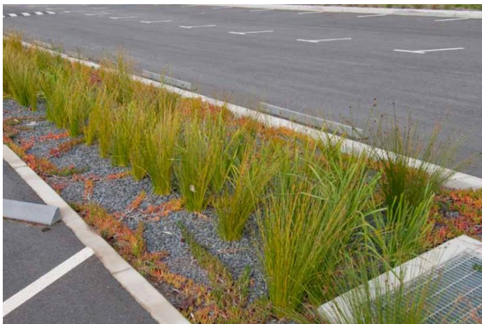
Figur 20. Exempel på makadamdike 1 som täckts med växter och gräs (Foto: SKISSBILD).
