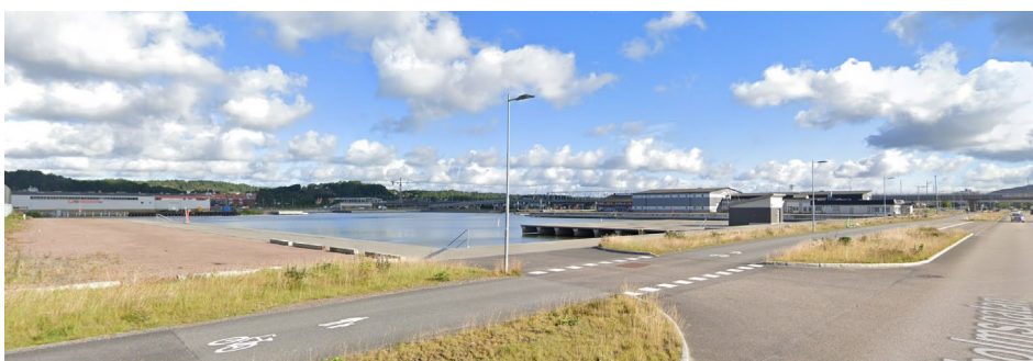
Figur 7. Detaljplaneområdet sett från sydöstra delen av Marieholmsgatan mot nordväst och delområde 4. Källa: Google maps (hämtad 251022).
