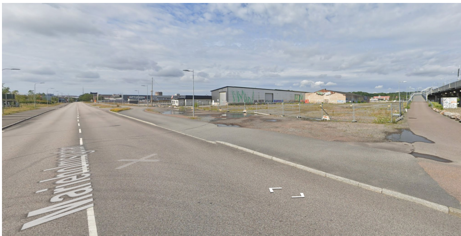
Figur 6. Detaljplaneområdet sett från nordöstra delen av Marieholmsgatan mot sydväst och delområde 4. Marieholmsbron skymtar till höger i bild. Källa: Google maps (hämtad 251022).
