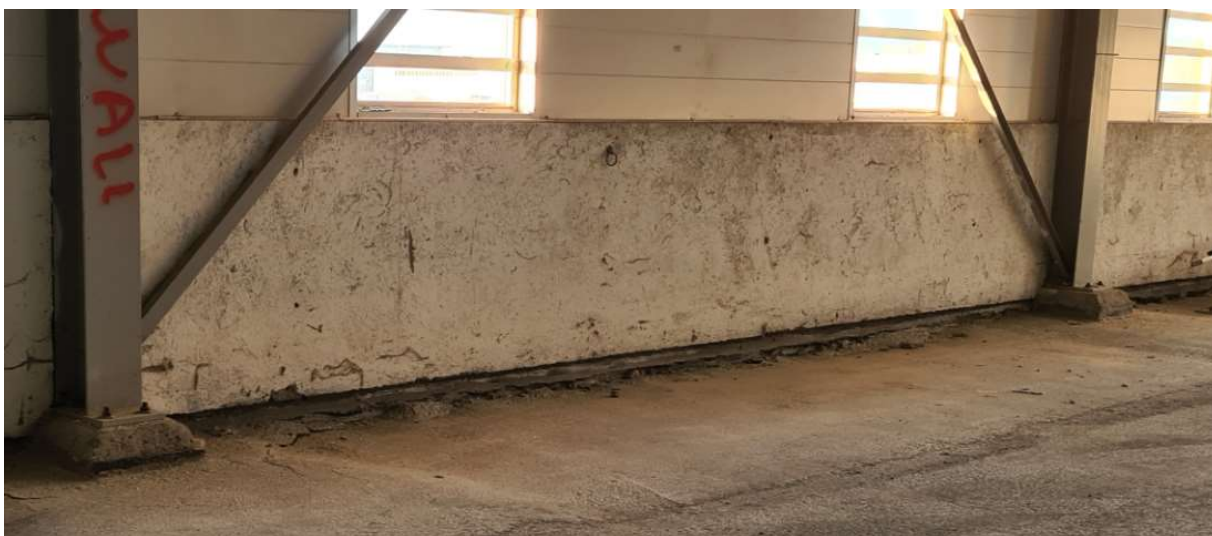
Figur 2. visualisering av sättningar inom befintlig byggnad
