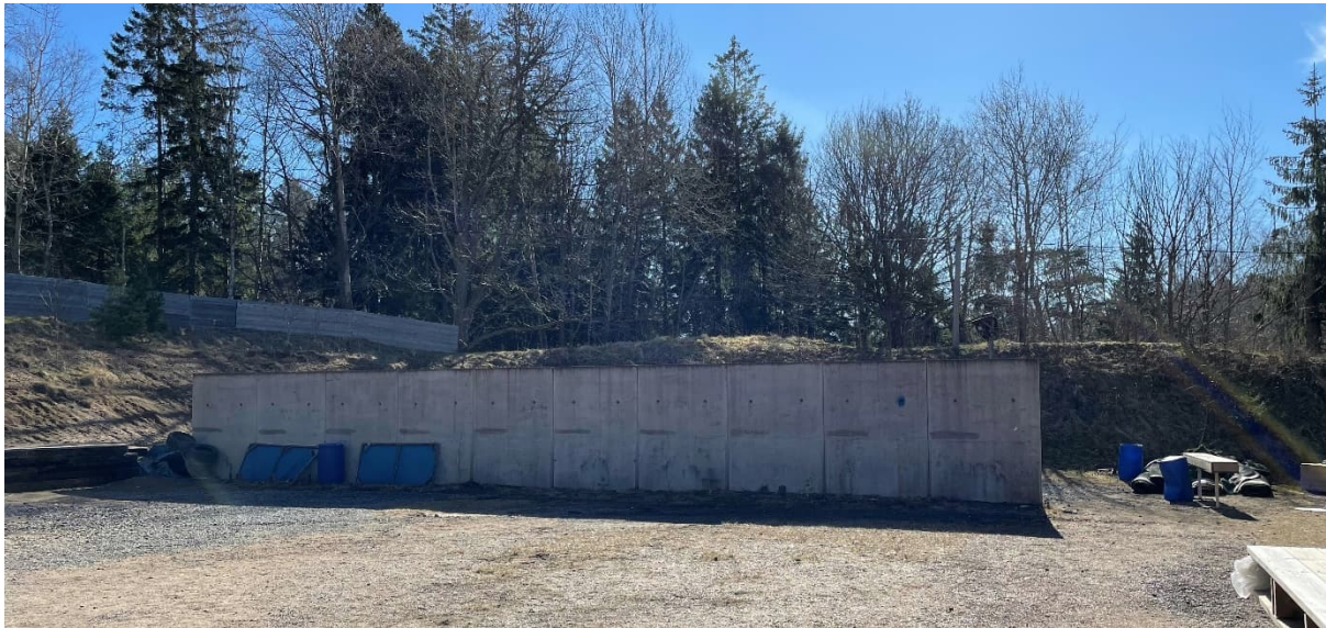
Figur 5. Foto av betongväggen längs skjutbanan Fältet.
