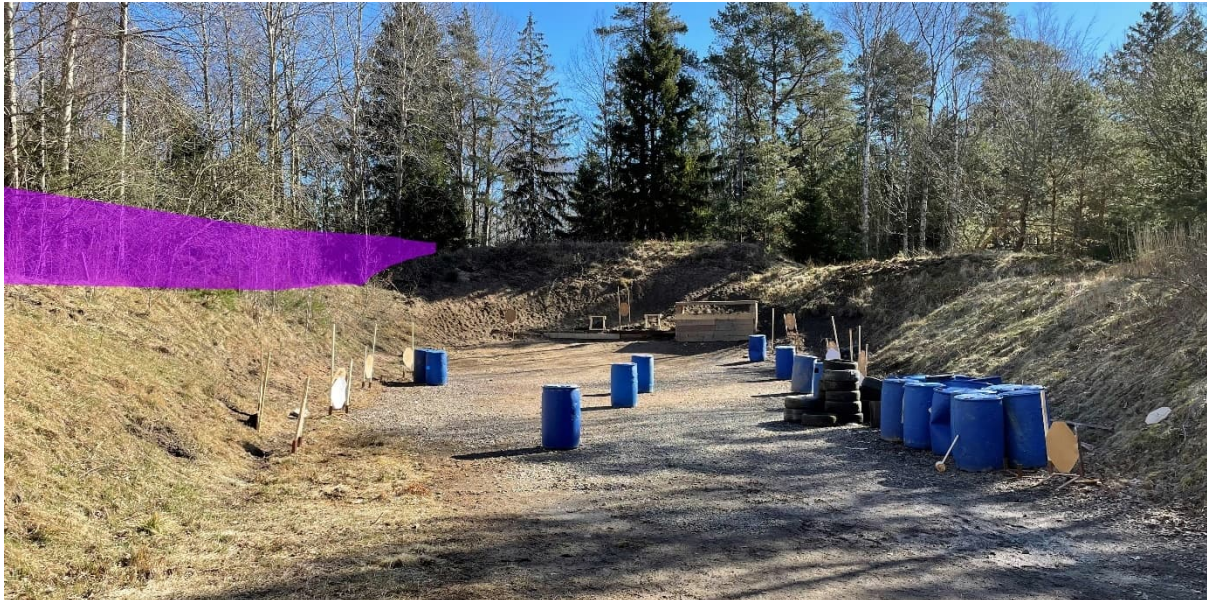
Figur 10. Det lila området markerar föreslagen justering av vallen så att ett ca 50 m långt avsnitt får markhöjd ca 91 m.ö.h.
