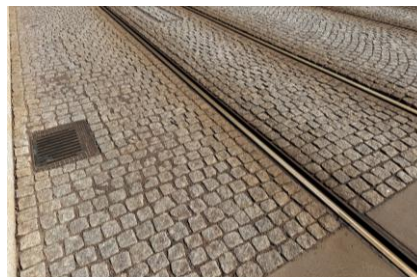
Figur 3-1 Vignolräl (járnvägsräl) till vänster och gaturäl (rännskena) till höger (Foto: PG Andersson)
