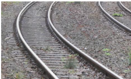
Figur 3-1 Vignolräl (járnvägsräl) till vänster och gaturäl (rännskena) till höger (Foto: PG Andersson)
