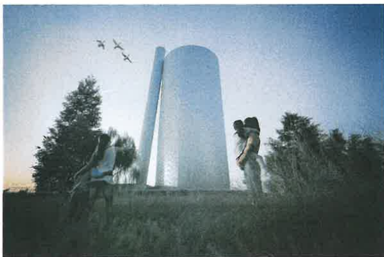
Figur 5. Planerad ackumulatortank i Gullbergsvass. Förslaget "Helan och halvan" utsågs till vinnare i en gestaltningstävling.
