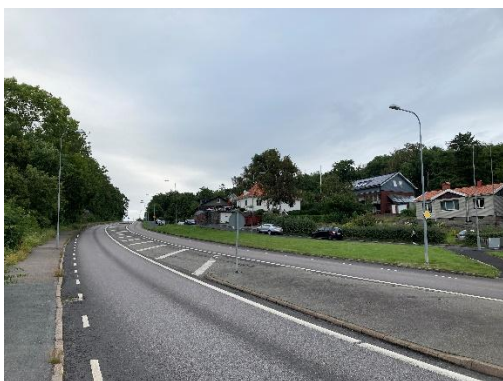
Grevegårdsvägen sedd norrut, SBF
