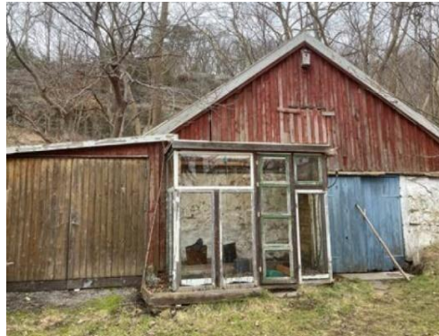
Källarvind med påbyggt garage. WSP
