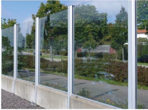
Exempel på bullerskärm i glas, Nordan, GNF Källa: http://www.gnf.eu/bullerskarmar/
