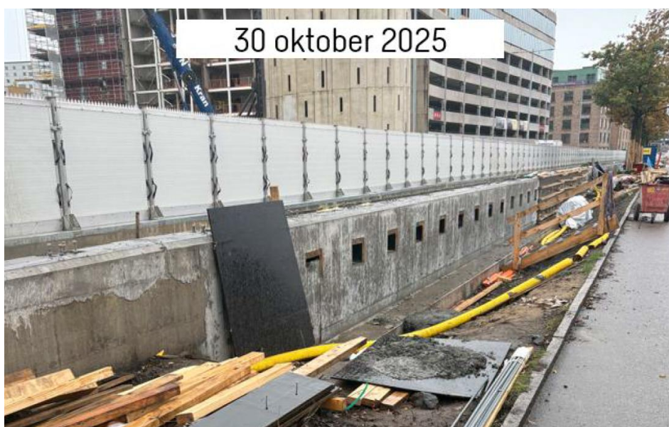
Figur 2-14. Pågående arbete med högvattenskydd i Andréegatan/Oscarsleden (Foto: Sweco 2025)
