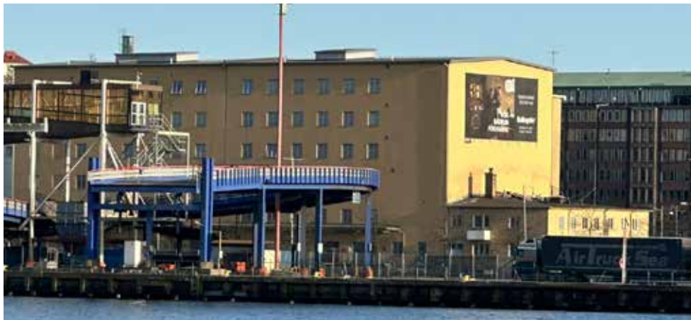
Figur.51: Kylhuset sett från norr med den enda fasaden med fönster samt anslutande kontorsbyggnad med tegelfasader i väster.
