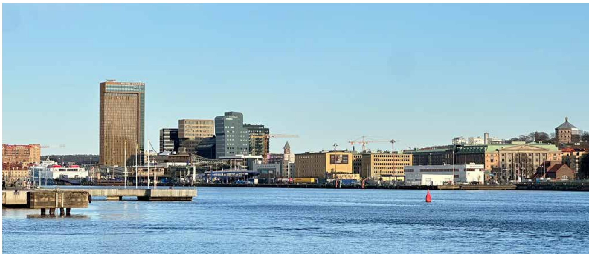
Figur.5: Kylhuset i sitt stadsmässiga sammanhang. Här syns Göta Älv, Draken vid Järntorget, de nyligen uppförda kvarteren på Järnvågsgatan och Masthamns-gatan, Vasakyrkans torn, Stena Line-terminalen, Kylhuset, Elof Hansons kontorsbyggnader, Första Långgatan, Amerikahuset och Skansen kronan.
