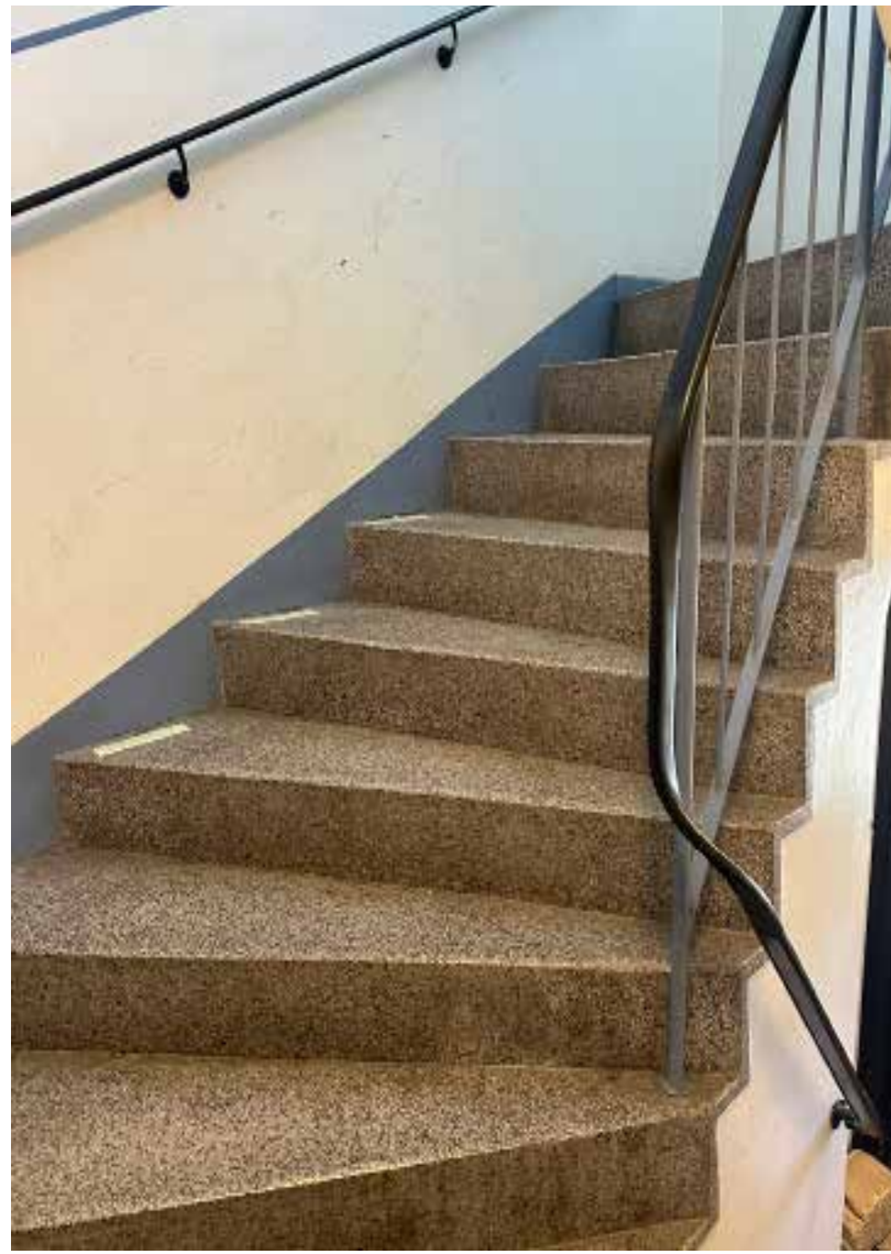
Figur.42: Trapphuset med trappa i terazzosten med järnräcken med svarta plasthandledare.
