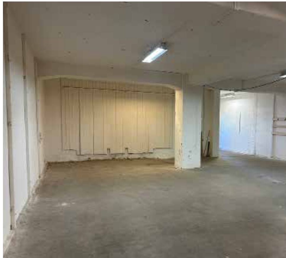
Figur.33: Kylrum med betongkonstruktioner, pelare och träpanel på vägg.
