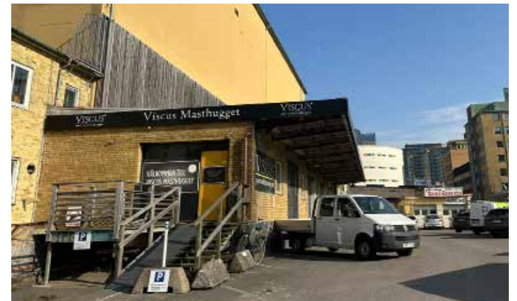
Figur.29: Södra fasaderna med den anslutande gårdsmiljön med garagen samt tillbyggnaden i tegel med skärmtak.
