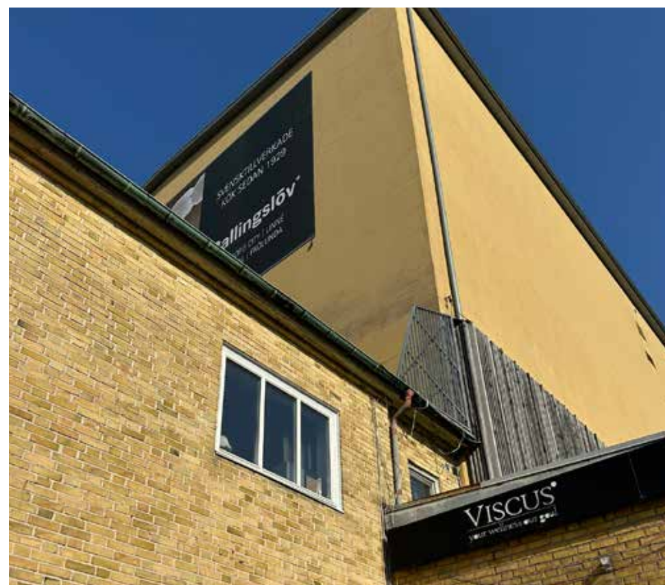
Figur.8: Mötet mellan kontorsbyggnaden, kylhuset samt tillbyggnaden för in- och utlastning.
