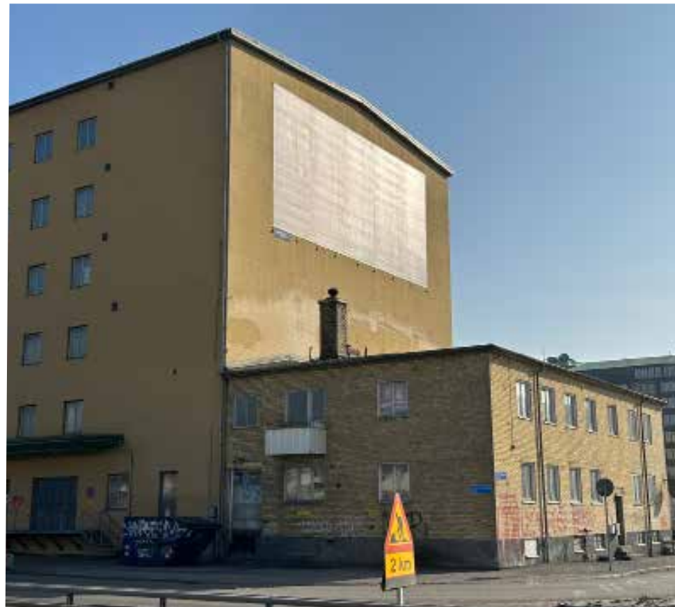
Figur.27: Kylhusets och kontorets norra och västra fasader mot Andréegatan och Östra Sänkverksgatan.
