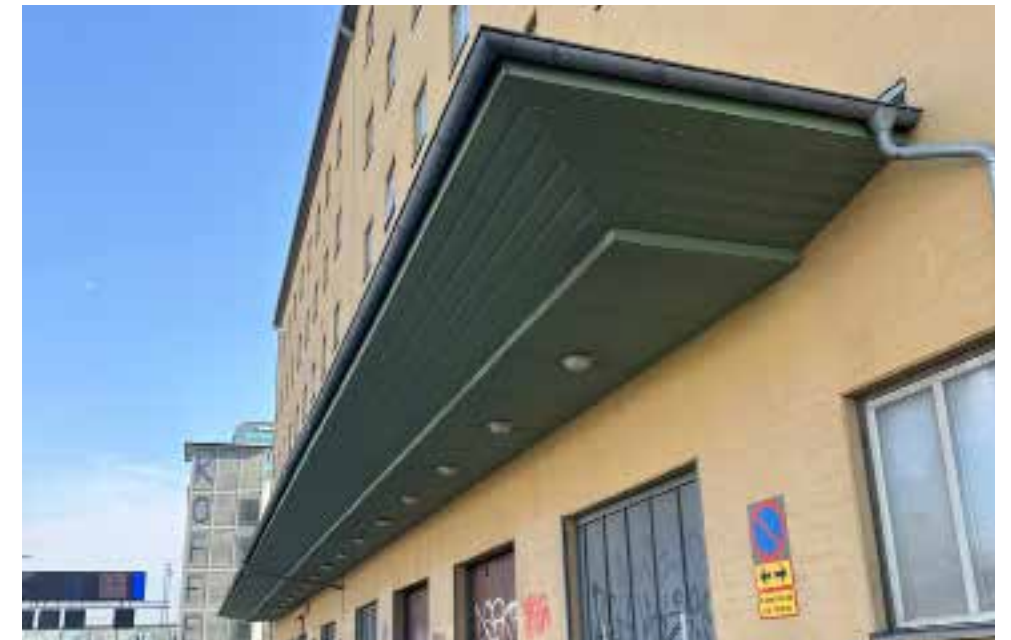
Figur.30: Det återskapade skärmtaket i norr av fibercement ovan lastbryggan.
