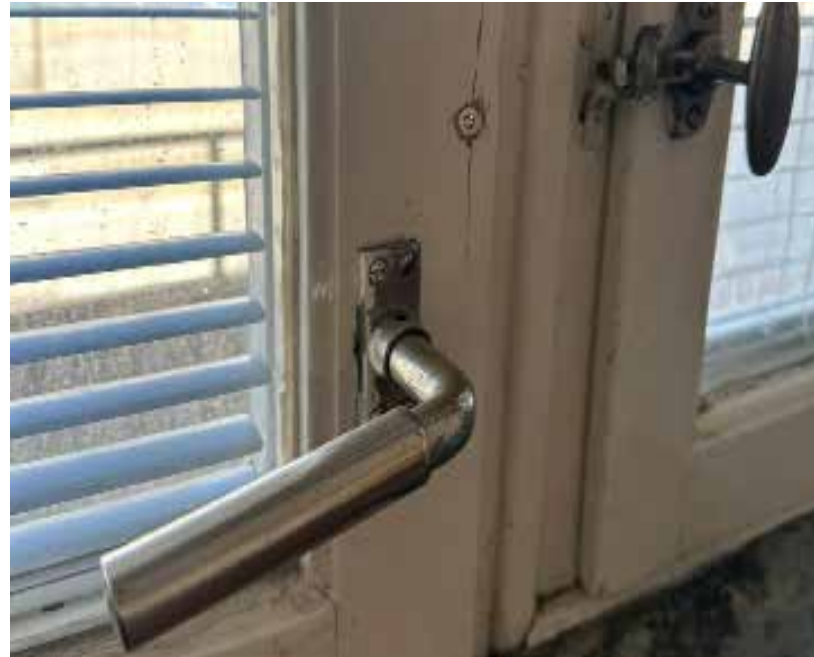
Figur.40: Detaljbild på ursprungliga fönster och dörrar av trä med beslag av metall.
