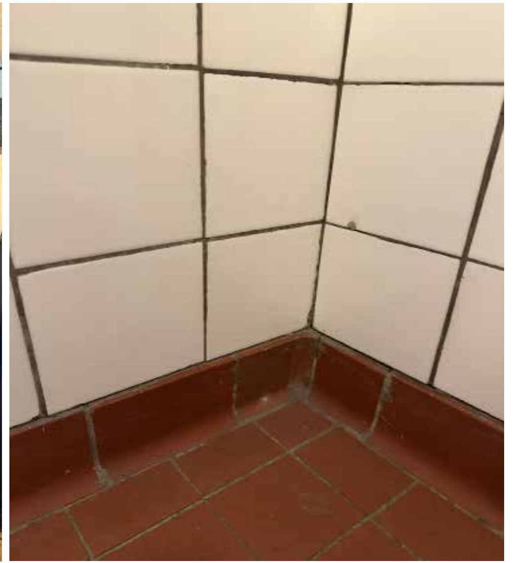
Figur.44: Toalett med ursprungligt golvklinkers och väggkakel i kontoret.
