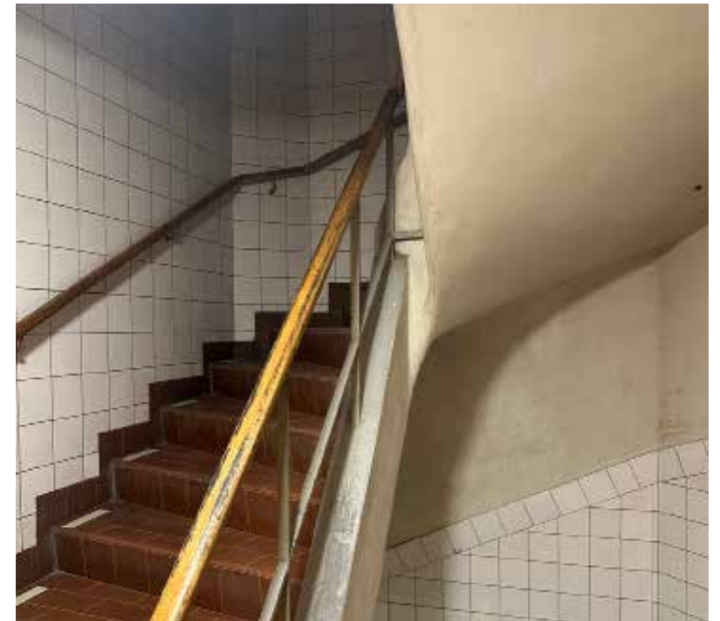
Figur.32: Trapphus med ursprunglig betongkonstruktion, kakel, klinker och trapppräcken.
