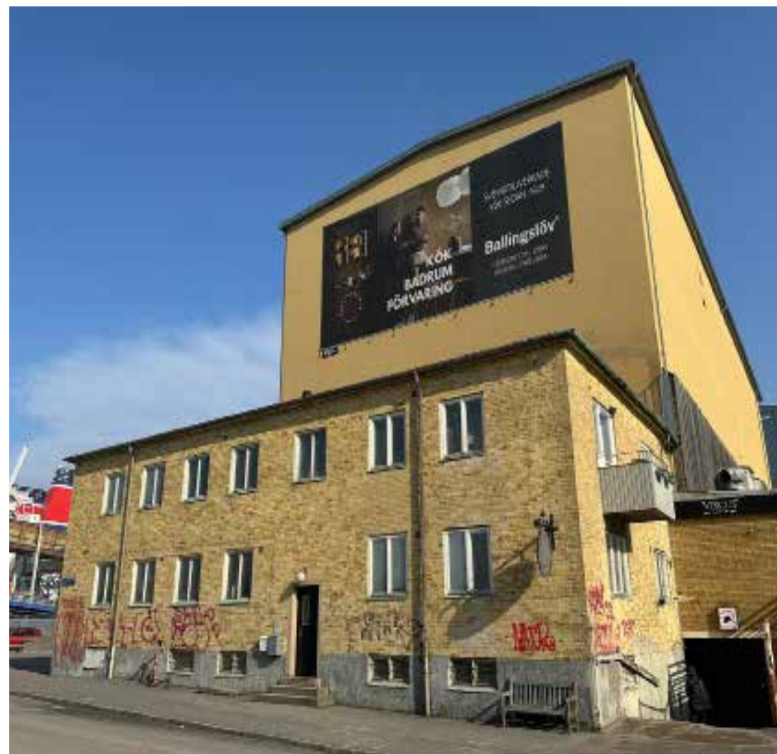
Figur.37: Kylhusets höga västra fasad utan fönster och kontorsdelens gula tegelfasader med delvis ursprungliga fönster och balkong.
