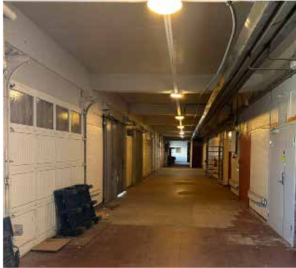
Figur.35: In- och utlämningshallen med lastportarna i norr. På bilden syns ursprungliga glasade träportar till vänster samt bevarat klinkergolv i terrakotta.
