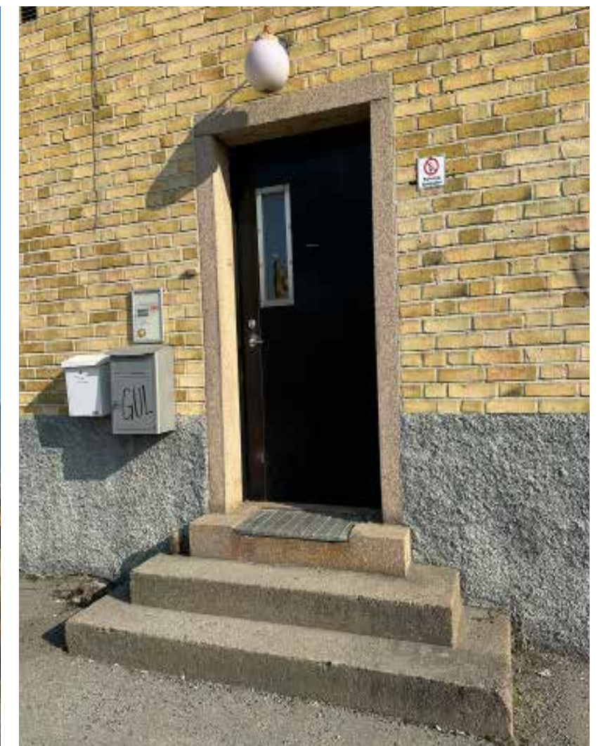
Figur.36: Ursprunglig trappa och dörrumfatning i granit med en bevarad klotlampa. Dörren är utbytt till en ny i svart aluminium.
