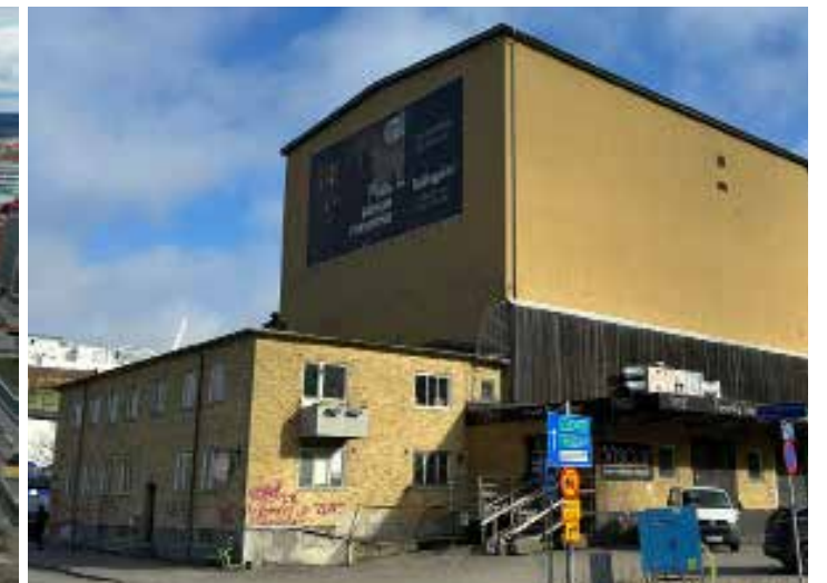
Figur.55: Kylhusets södra fasader med högdelen och kontoret.
