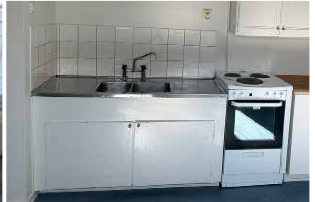
Figur.43: Ursprunglig köksinredning med skåp och diskbänk samt kakel i den tidigare lägenheten i söder.
