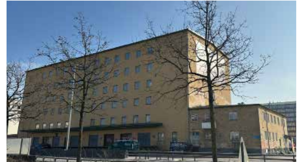
Figur.31: Kylhusets norra fasad med symmetriskt placerade fönster.
