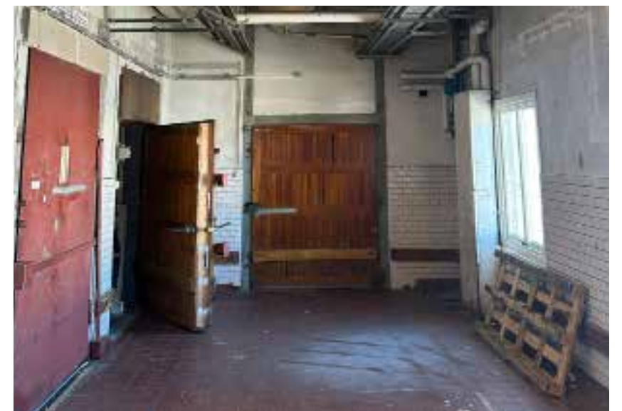
Figur.50: In- och utlastningshallen med ursprungligt kakel, klinker och lackade trädörrar med beslag.
