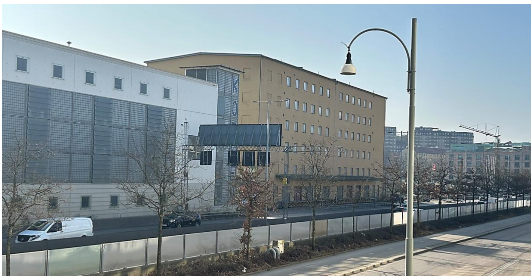
Parkeringshuset Koffen i förgrunden och Kylhuset till höger i bild utmed Andréégatan.
