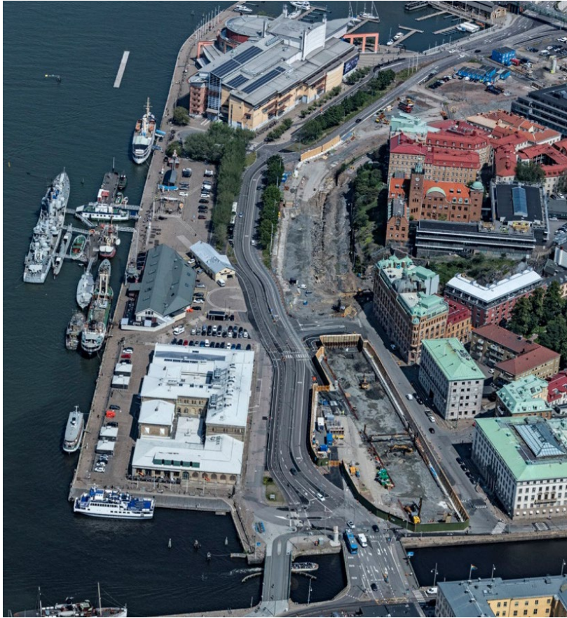
Bild: Packhusplatsen under arbetet med Västlänken.
