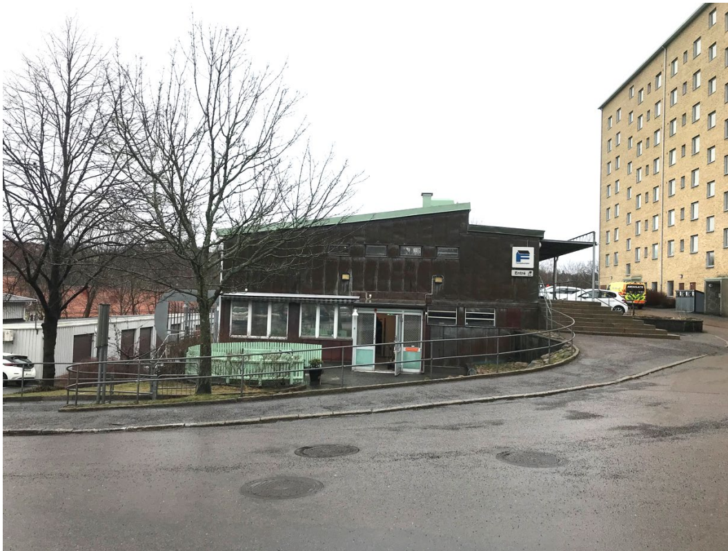
Figur 4 Foto över befintligt distriktskontor på aktuell fastighet.
