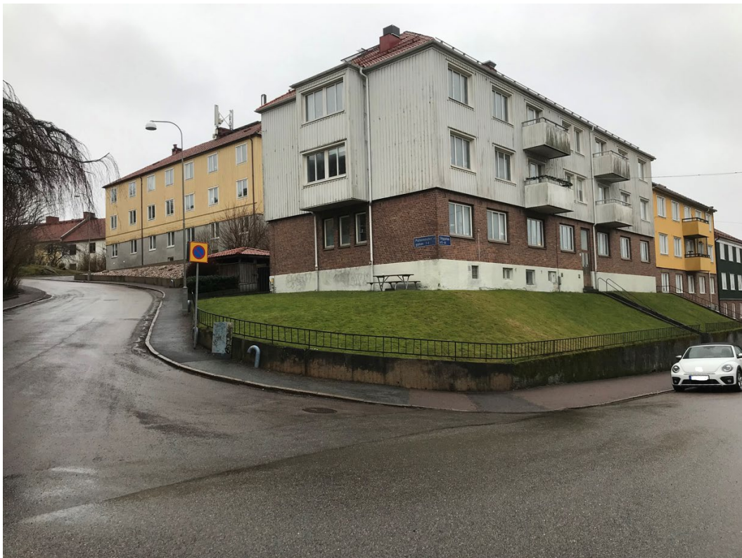
Figur 9 Foto över stödmur längs Paternostergatans västra sida och i anslutning till Såggatan.
