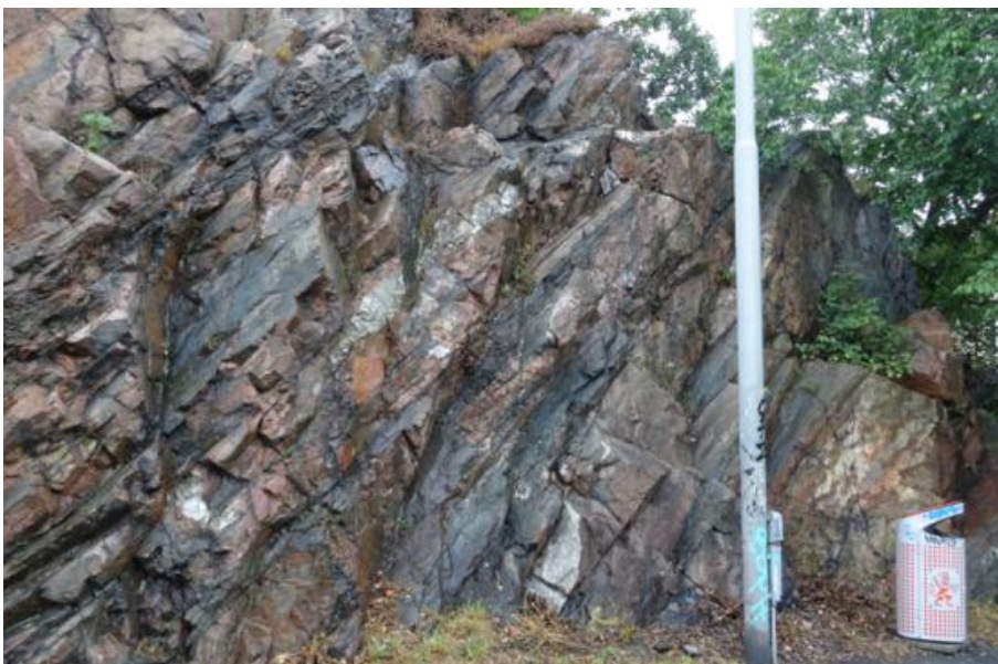
Bild 12. På lokal zon med mer uppsprucket berg (Pegmatitzon) vid Såggatan strax norr om aktuell fastighet.
