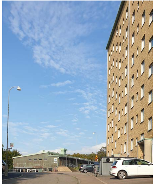
Spelet mellan de höga skivhusen och den låga butikbyggnaden skapar spänning i stadsbilden.
