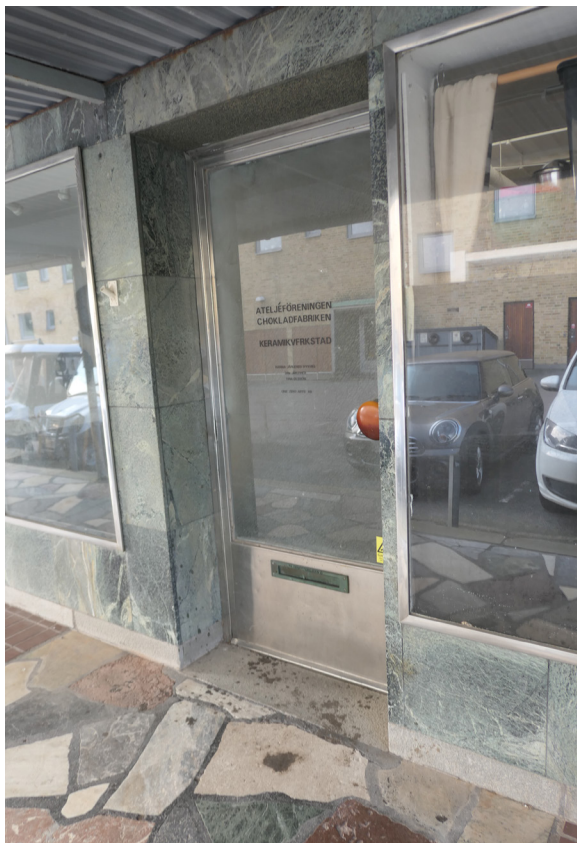
Ursprungligt dörrblad av rostfritt stål.
