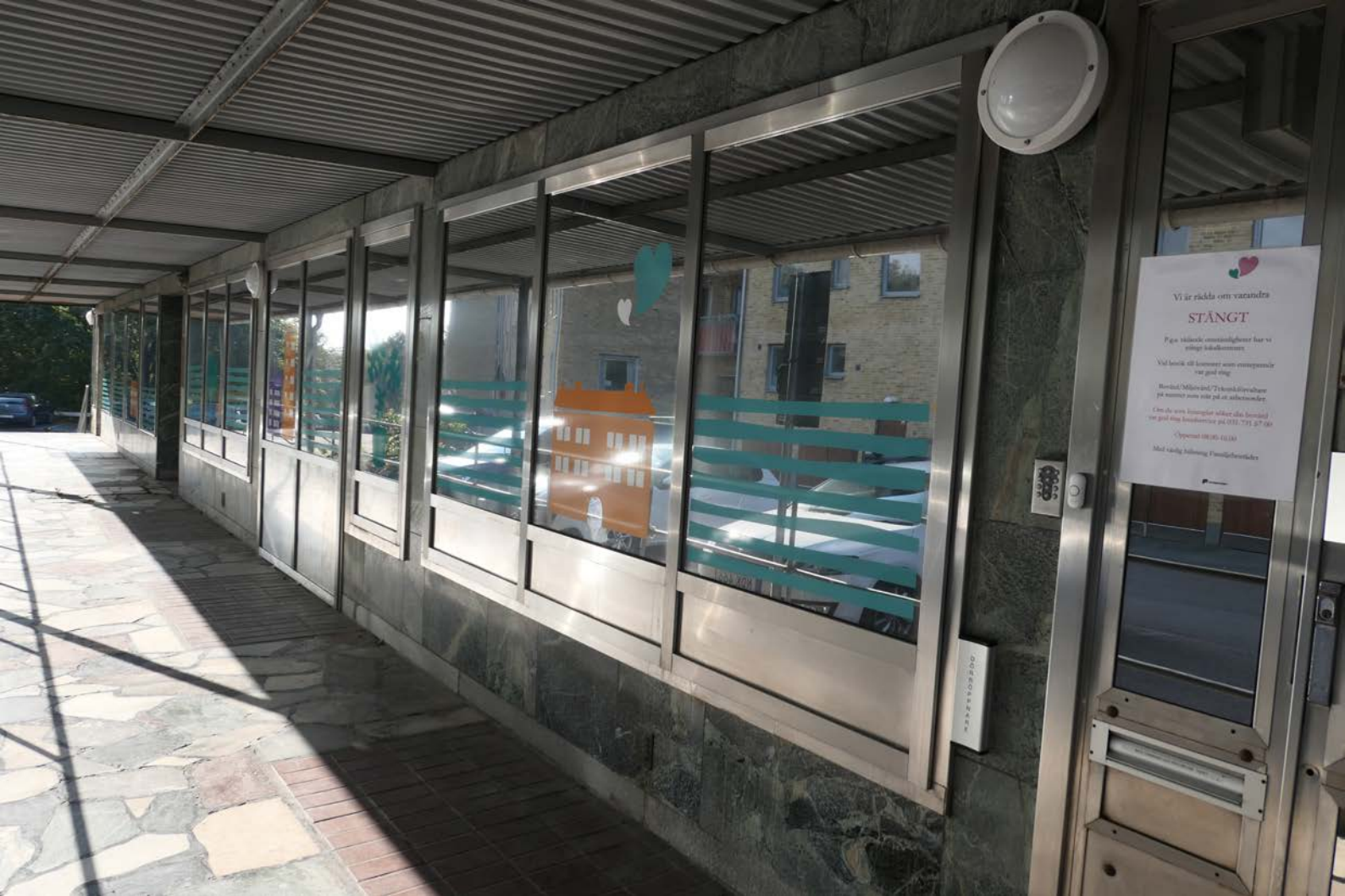
På 1990-talet byttes flera skyltfönster och dörrar mot nya, vilket förtagit det i övrigt välbevarade uttrycket.
