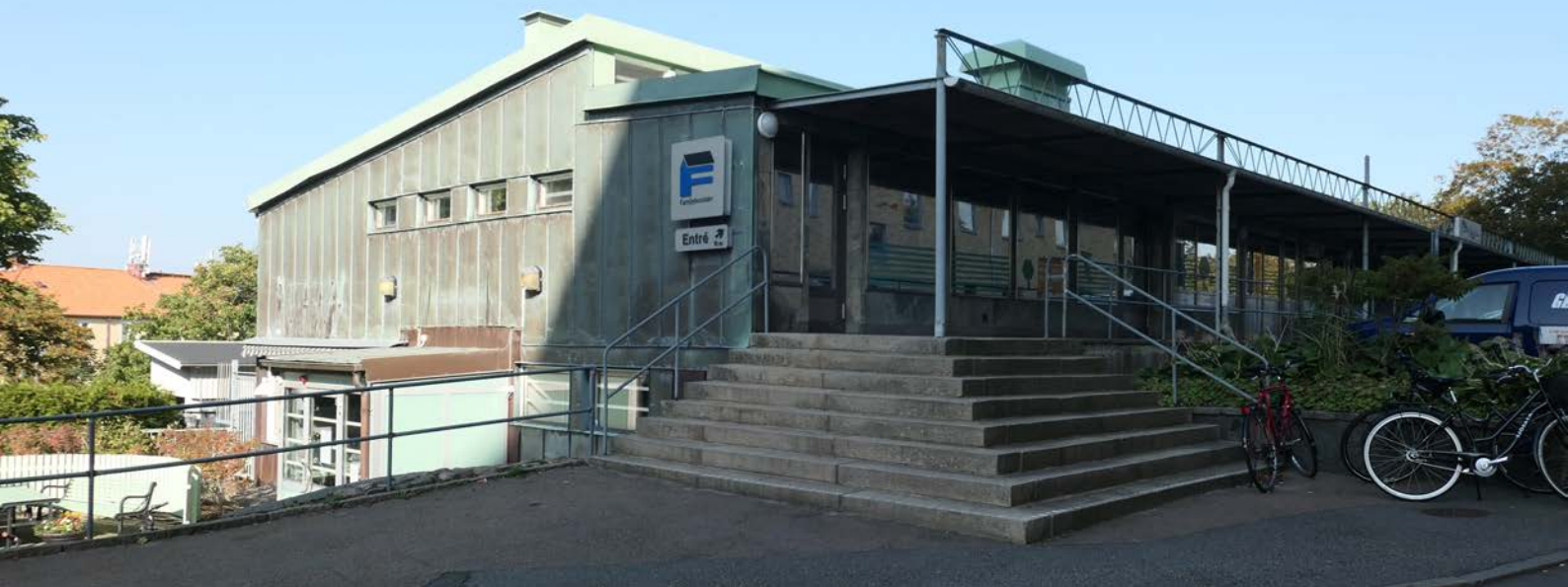
Butiksfasad samt gavelfasad mot sydväst. Utmed butiksfasaden, i förhöjt läge, löper ett skärmtakstäck gångstråk. Fritrappan tillkom under 1990-talet.
