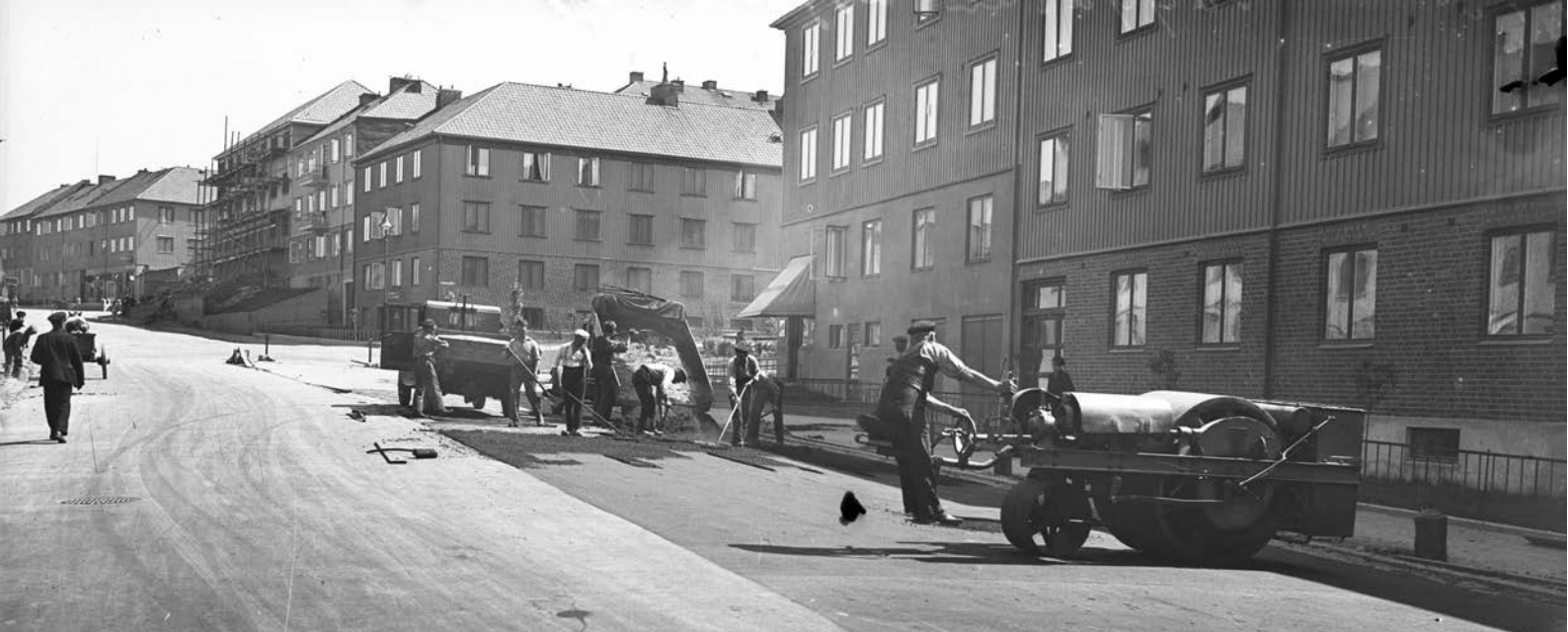
Fotografi över Söggatan från år 1935. Söggatan kantas av nyuppförda landshövdingehus vars fasader mot gatan skapade väldefinierade gaturum. De nya landshövdingehusen gavs en enkel och avskalad fasadarkitektur utan fasaddekor. Taket utfördes som tegeltäckta sadeltak och fasaderna kläddes med stående locklistpanel och försågs med ospröjade 2-luftsfönster. Sockelvåningarna utfördes i tegel. Källa: TT-bild.
