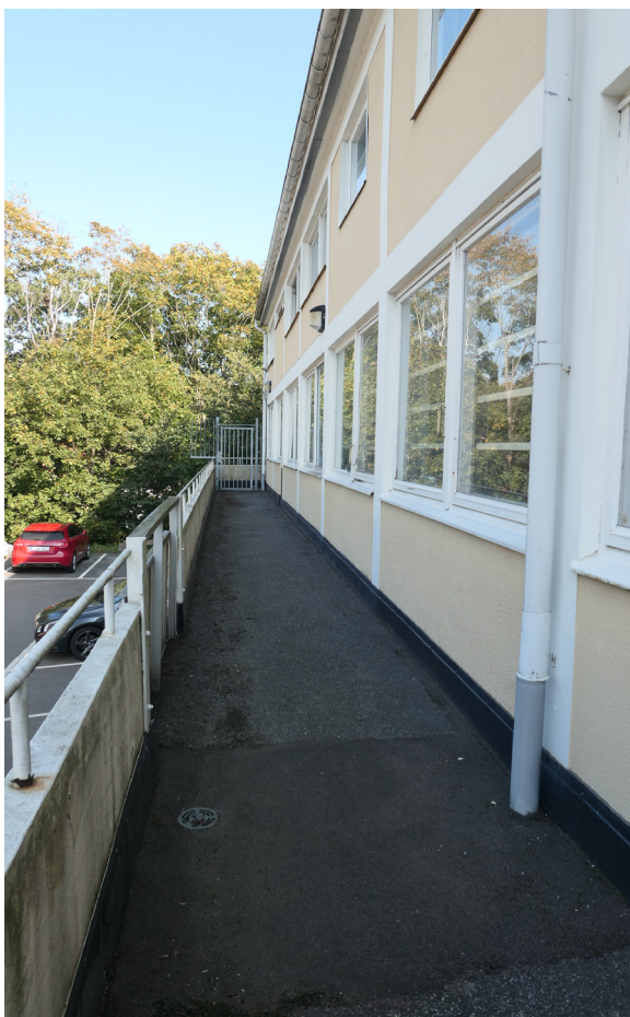
Loftgången utmed den nordvästra fasaden.
