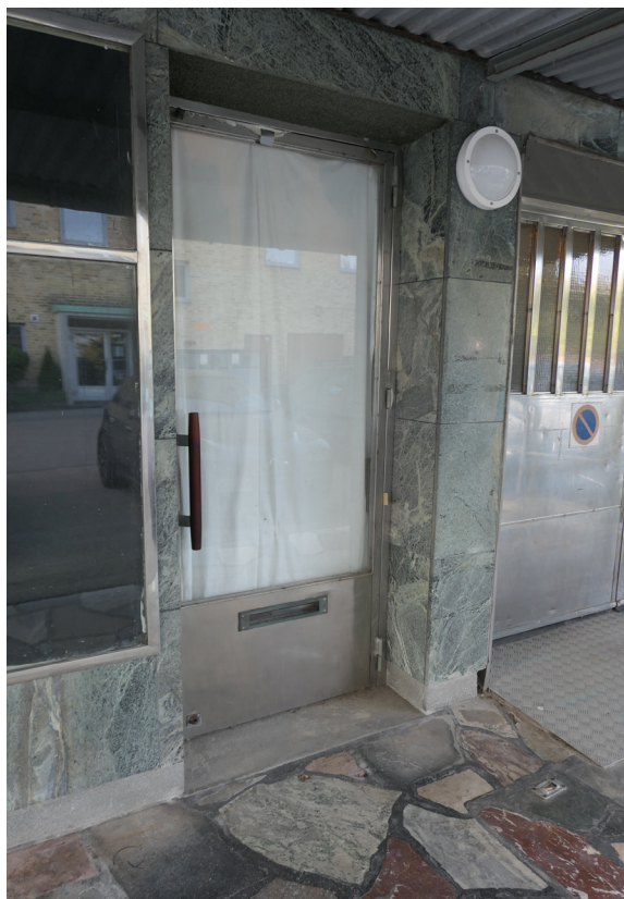
Ursprungligt dörrblad av rostfritt stål.
