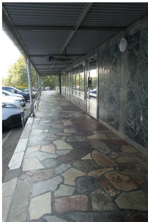
Utmed butiksfasaden löper ett gångstråk under skärmtak med ursprunglig markbeläggning.
