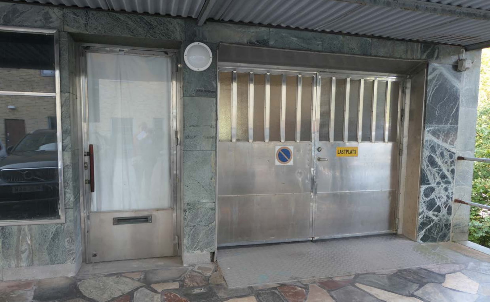
Ursprungligt dörrblad av rostfritt stål. Slagporten till höger i bild satt ursprungligen i garagevåningen, men flyttades till sitt nuvarande läge på 1970-talet.
