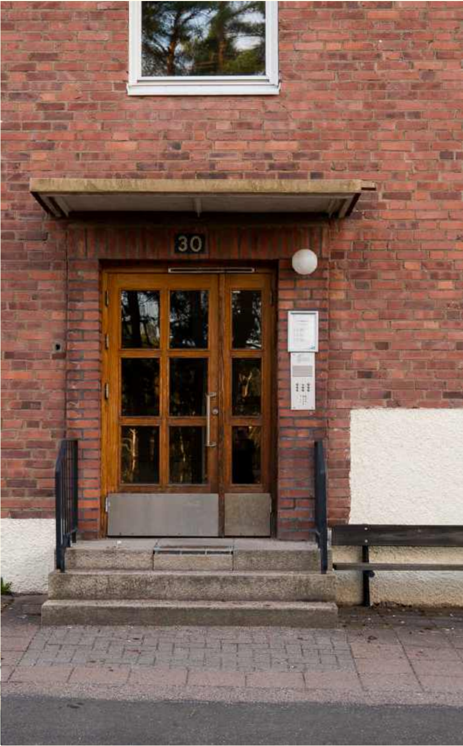
Figur. 2 Exempel på Norra Kortedalas enkla men omsorgsfulla detaljering. Här vid Årstidsgatan.
