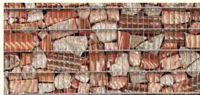
Figur. 51 Gabion med tegelkross.
