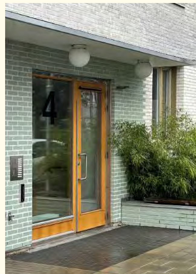
Figur. 19 Betonggatan, Limhamn, Johan Celsing Arkitektur. Entré med skärmtak och markerat murverk runt dörr.
