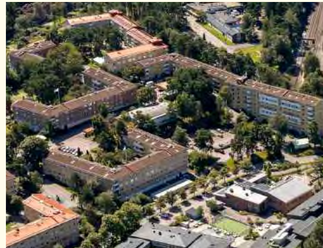
Figur. 15 Befintlig bostadsbebyggelse i delområdet. Skolbyggnader på norra sidan Aprilgatan.
