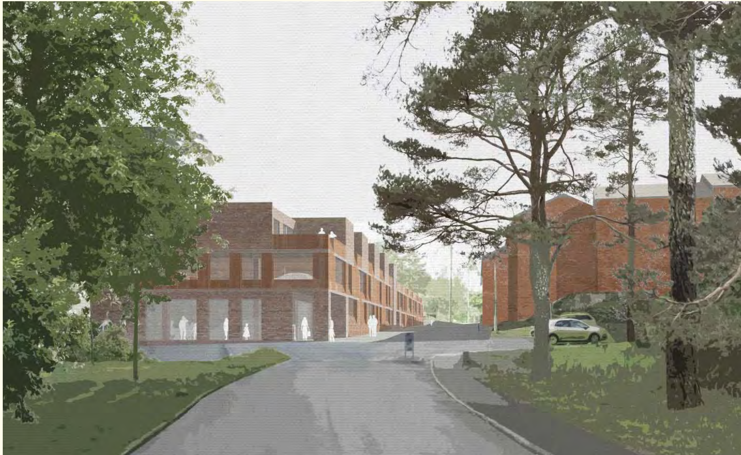
Figur. 54 Kontorsdelen vänder sig mot spårvagnshållplatsen och Årstadstorget norr om byggnaden. Fasadalternativ med sockel av gabioner med tegelkross, öppna väggar av cortengaller och Täta väggar av tegel.
