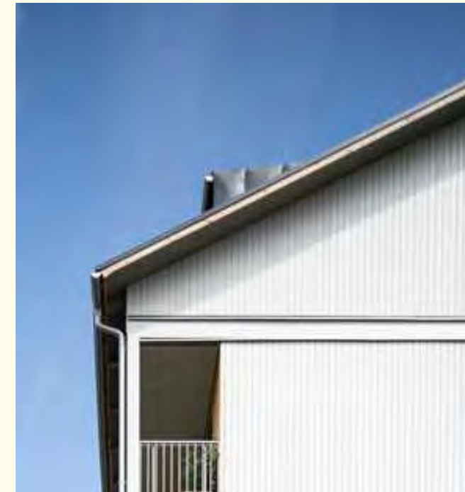
Figur. 25 Ektorpsbacken, Nacka, Dinell Johansson Arkitekter. Visuellt tunt tak med takutsprång.
