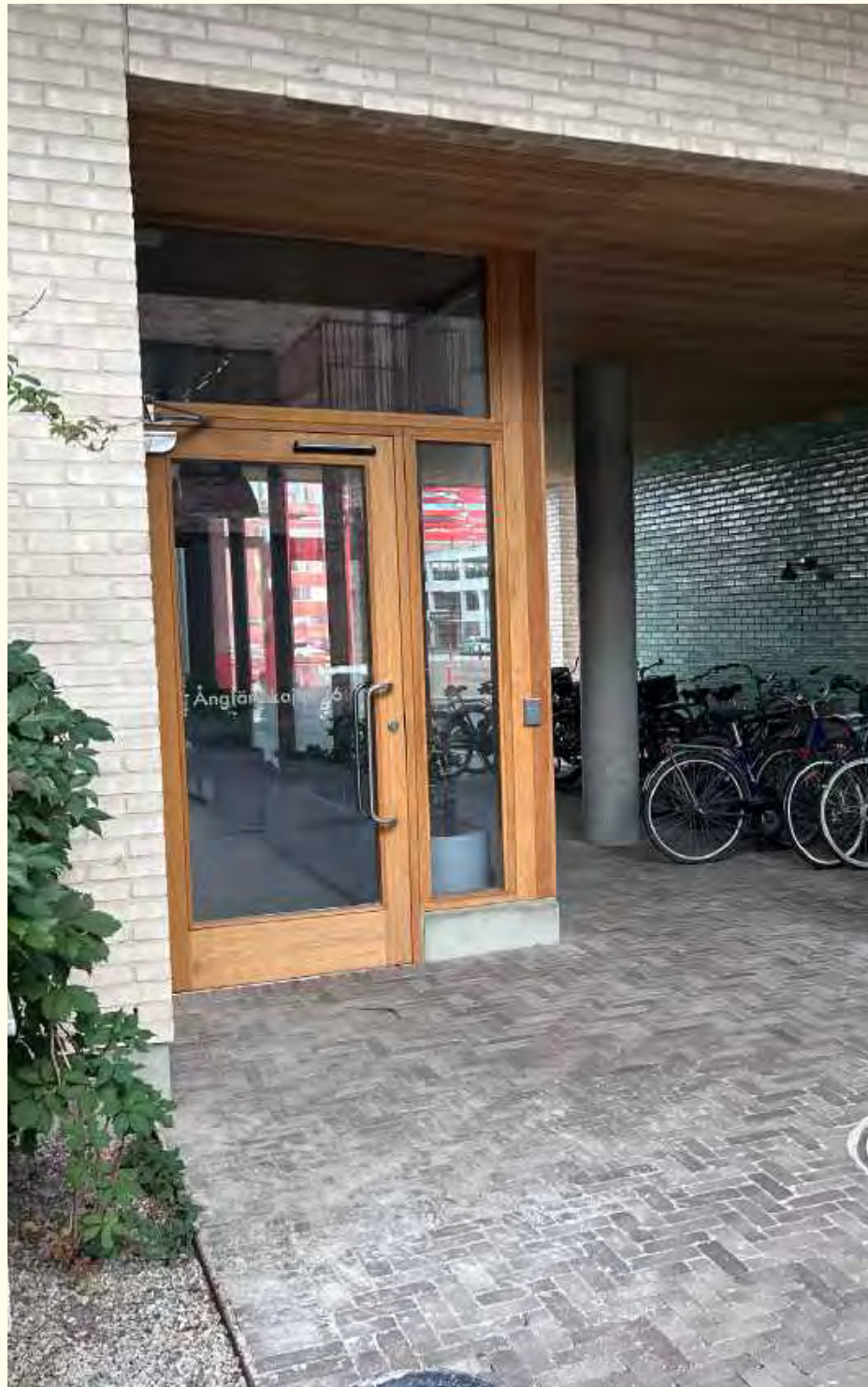
Figur. 26 Kv. Fyrskippet, Malmö, Johan Celsing Arkitektur. Portgång med indragen entré och omsorgsfullt valda material.
