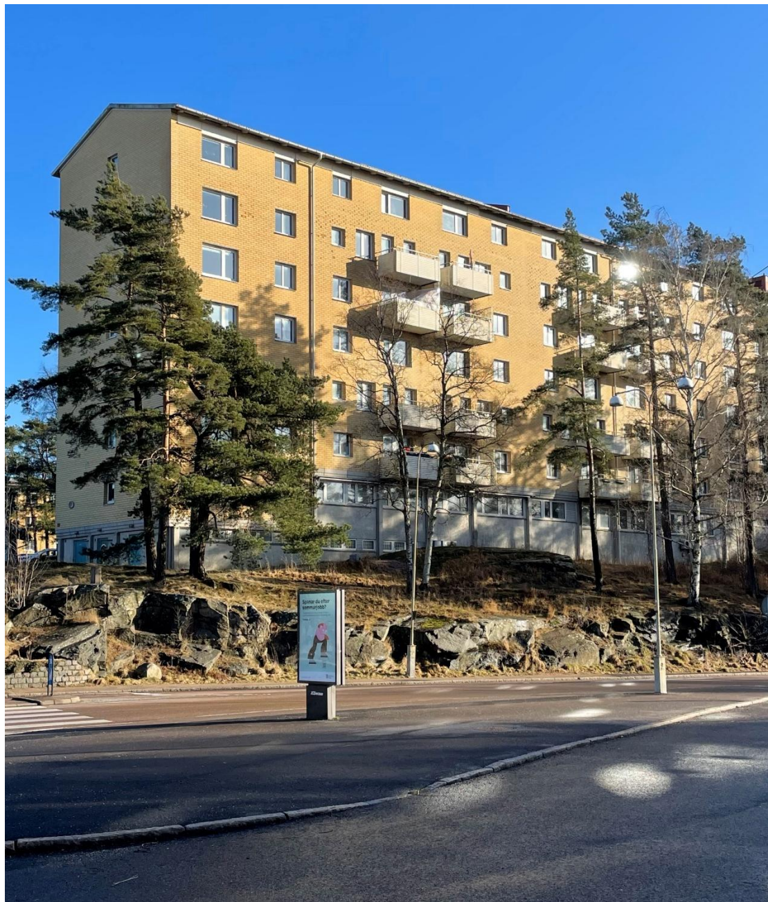
Byggnadsordningen i lamellhusområdet har givit upphov till stor variation i höjd mellan den lägsta och högsta byggnaden, något som är särskilt märkbart utmed Januarigatan.
