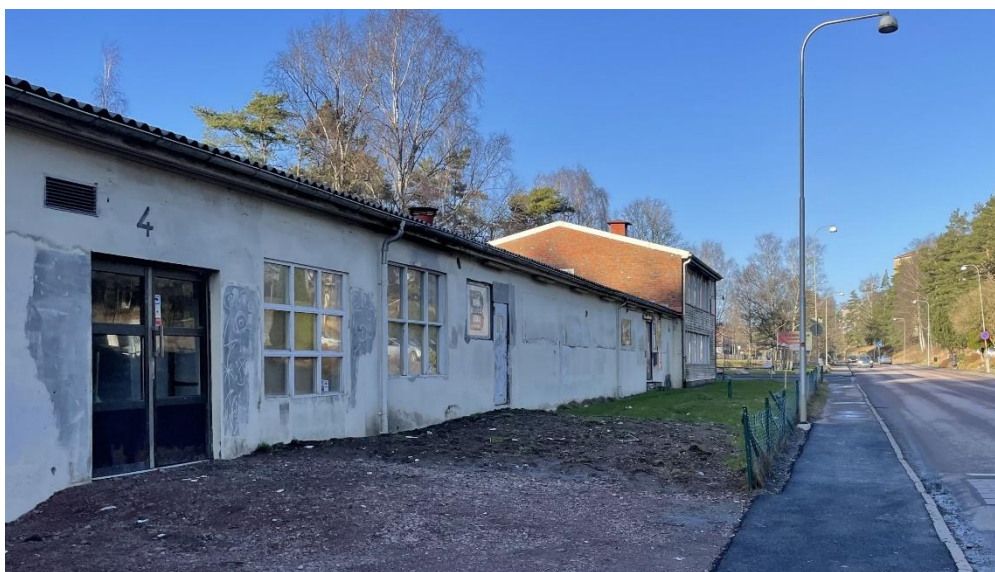
Fönster och dörrar har satts igen och tagits upp efter behov.
