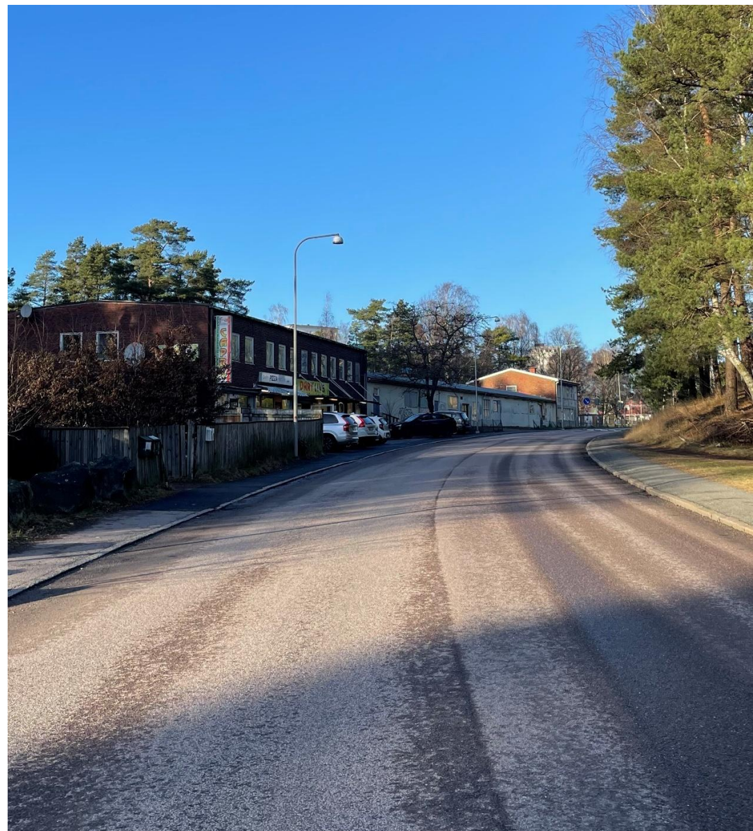
Industribyggnader utmed Januarigatan.
