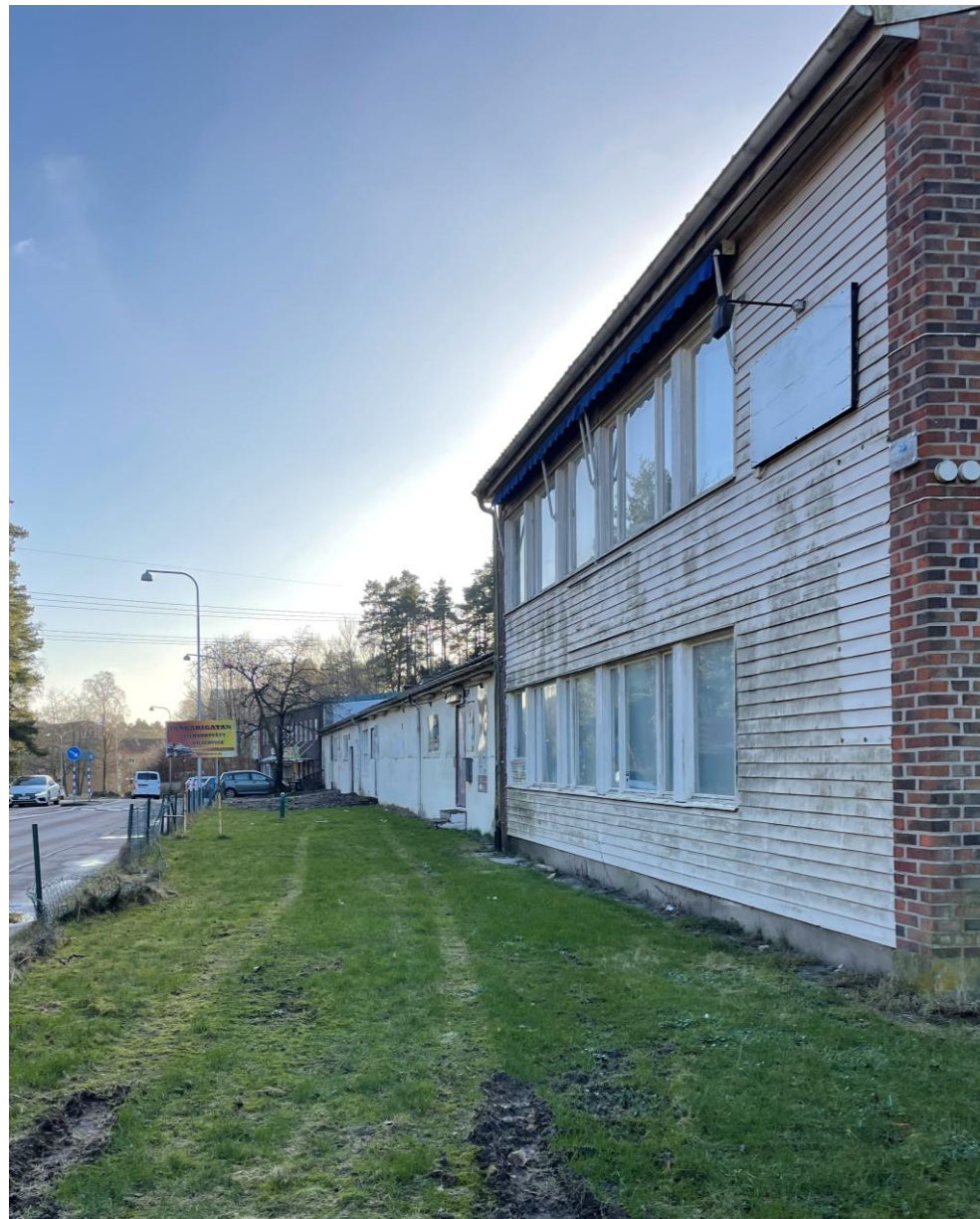
Industribyggnaderna har fasader i tegel, puts och liggande panel.
