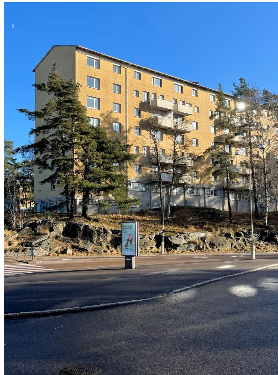
Lamellhusen utmed Januarigatan har olika byggnadshöjder anpassade efter bergets varierande höjd.
