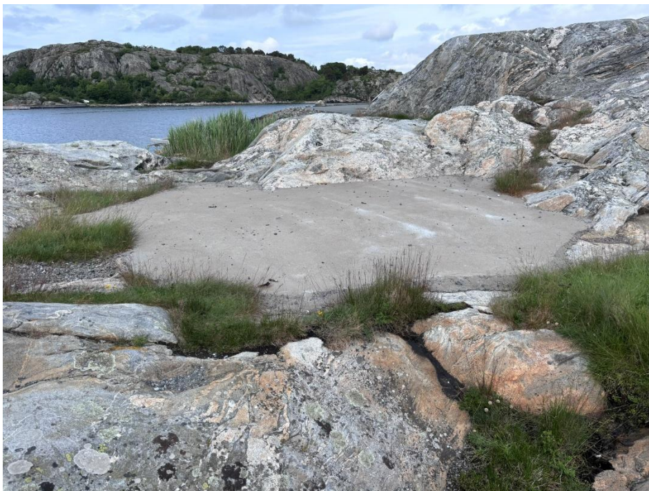
Betonggjutning i bergsskrevan i juni 2026.
