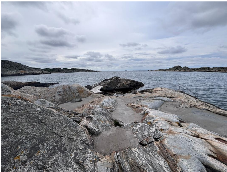
Betonggjutningar i bergsskrevor i juni 2026.
