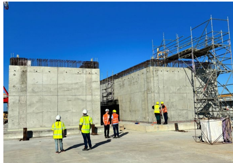
Gjutning av kassuner för påseglingsskydd.
