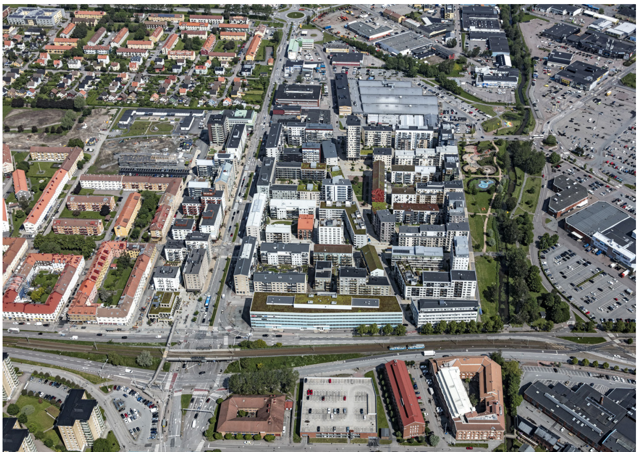
Figur 12 Vågmästareplatsen och den nya bebyggelsen väster om Kvillebäcken
