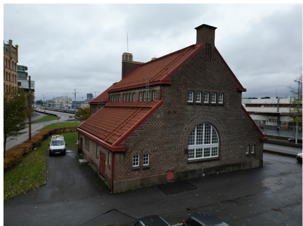
Bild: Fd Pumpstationen
