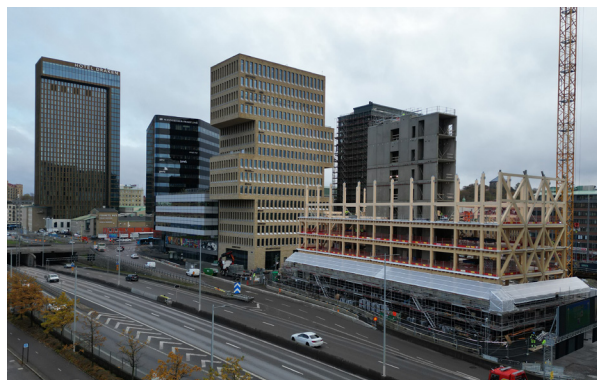
Bild: Ny bebyggelse vid Järnvågen under uppförande
