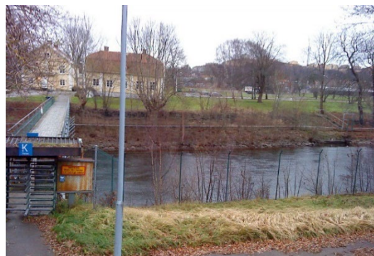
Fig. 7. Ledningsbro med gångförbindelse ovan, vy mot Sävenäs herrgård. Foto Norconsult.
