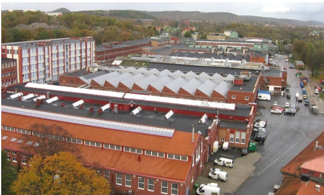
Fig. 14. Planområdet och dess taklandskap sett från SKF:s huvudkontor. I förgrunden M-verkstaden med två basilikaformade hallar, i mitten R-fabriken med sågandstak. Högre byggnad till vänster är K-fabriken med Bunkeberget där bakom. Foto Lindholm Restaurering.
