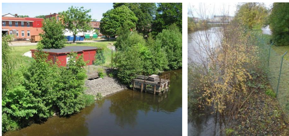
Fig. 8. Industriområdena på båda sidor om ån är inhägnade. Framför stängslen finns erosionsskydd, till stor del i form av makadamslänter. Foto Norconsult.
