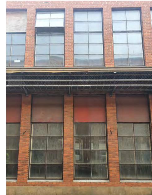
Tätt sittande, spröjsade stålfönster inom en struktur av smäckra tegelpelare. Bild: Johanna Lange
