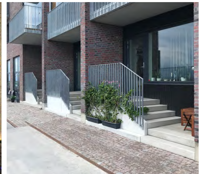
Ett annat sätt att möta gatans karaktär av industrimiljö. Gatsten och platsgjutet betong avgränsat av stål. Oceanhamnen, Helsingborg. Bild: Liljewall
