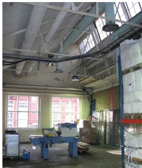
Fig. 39. T.h.: R-fabriken, invändiga detaljer, synliga takstolskonstruktioner och balkar, överljus och spröjsade fönster och rörinstallationer.
