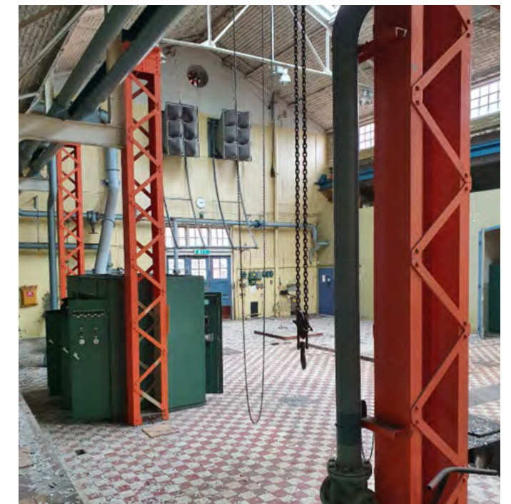
M-verkstaden med schackrutigt golv, fackverkspelare i signalfärg, kättingar från traversen och märklit utformade luftfilter ovan entréporten. Bild: Johanna Lange
