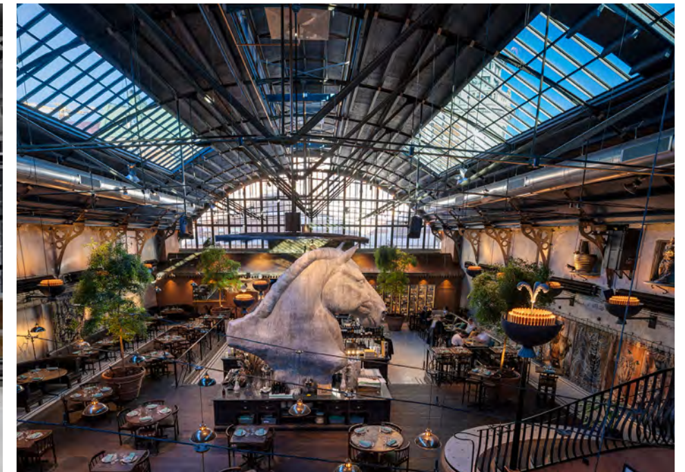
Bibehållna synliga takstolar i Artilleristallarna, Magasinsgatan, Göteborg. Bild: Göteborgs Bildbyrå / Kreativ Teknik
