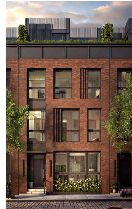
Takterrasser på indragna takvåningar ger en känsla av att husen är lägre och ger ett varierat taklandskap, Leroy street, New York. Arkitekt: Workshop/APD.
