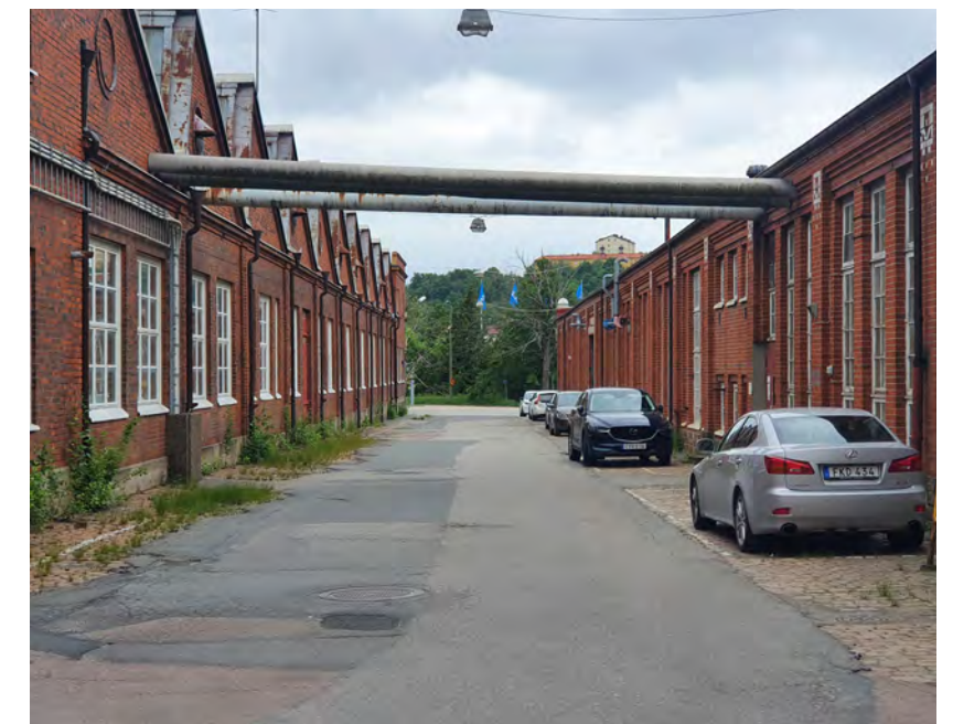
Tvärgatorna har en grön fond som utgörs av träd och sly utmed Säveån. Markbeläggningen utgörs av asfalt med inslag av gatsten. Foto: Johanna Lange.
