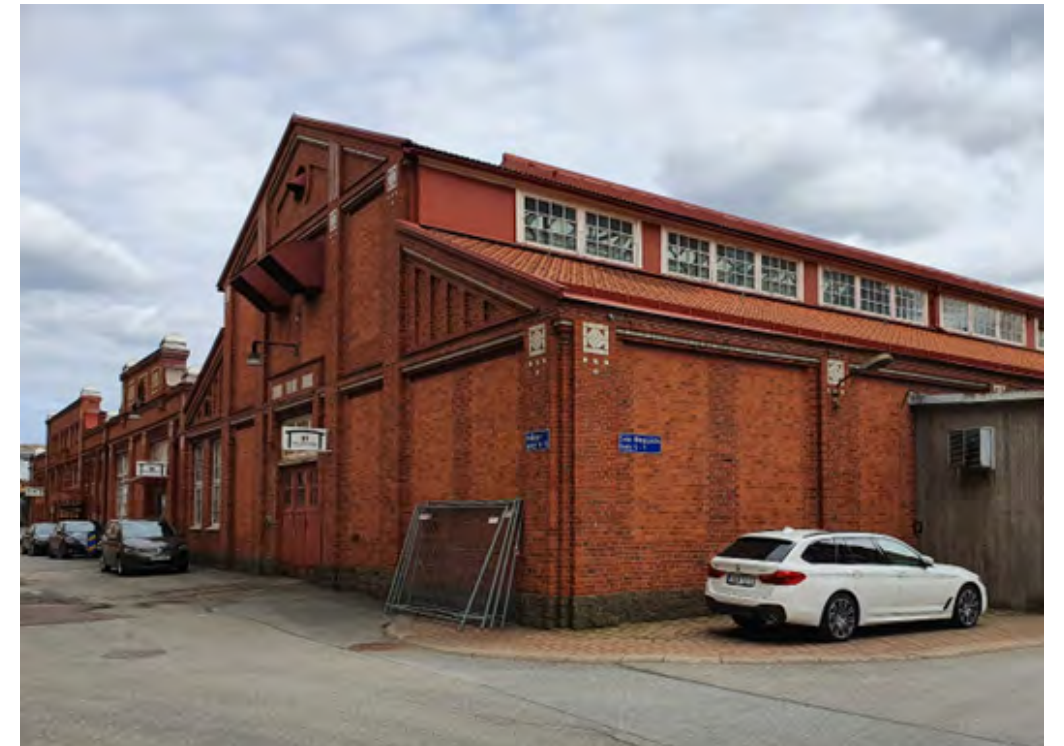
Igenbyggda fönsteröppningar kan öppnas upp på nytt. Bild: Johanna Lange
