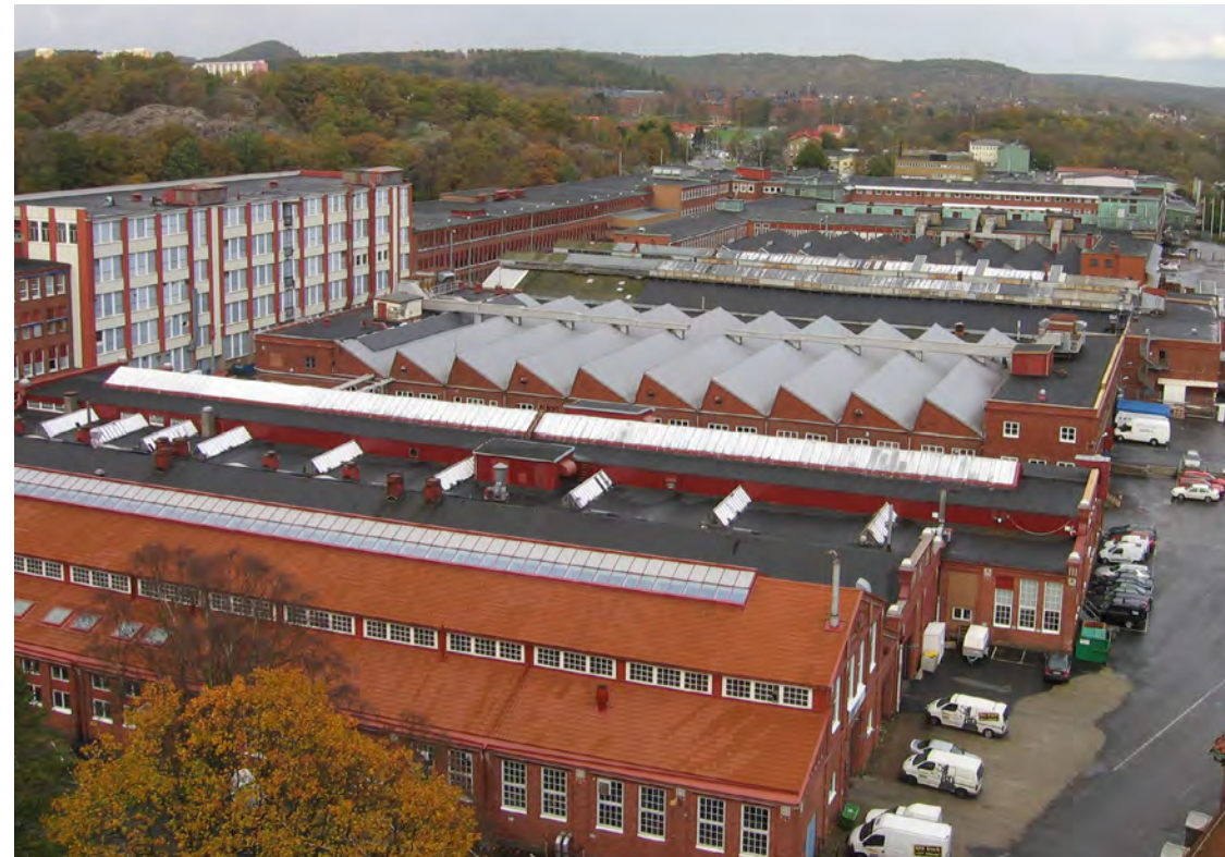
Vy över den inre delen av fabriksområdet med lägre byggnader och olika typer av fabrikstak. Foto: Johanna Lange.
