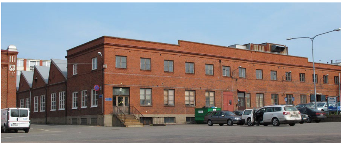
Fig. 19. Söderfasad mot Kullagergatan.
