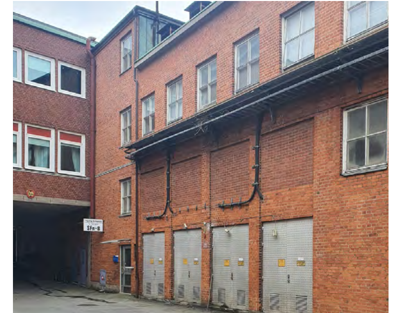
Portar i plåt, igenbyggda fönsteröppningar och en långsgående kabelstege. Fasaderna är robusta med inslag av installationer av tillfällig karaktär. Bild: Johanna Lange
