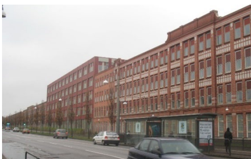
Fig. 12. C-, K- och A-fabrikernas fasader mot Artillerigatan
