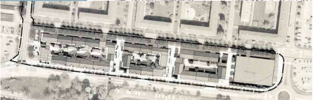
Bild: Illustration över pågående byggprojekt vid Distansgatan.
