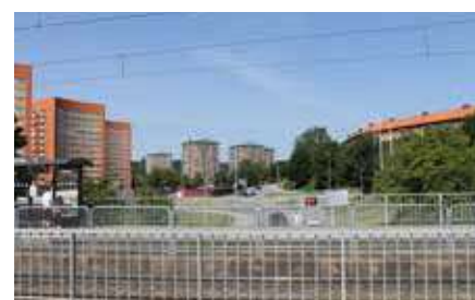
Bild: Marconigatans spårväg
