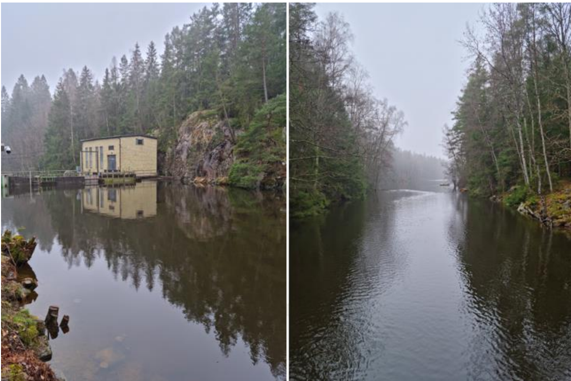
Figur 8: Till vänster: Solvedens vattenkraftverk. Till höger: Mjörns utlopp till Sävån uppströms Solveden.
