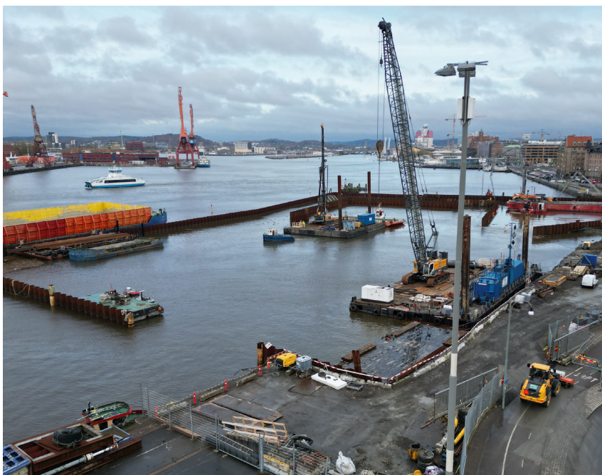
Bild över bygget av nya halvön vid Järnvågen
