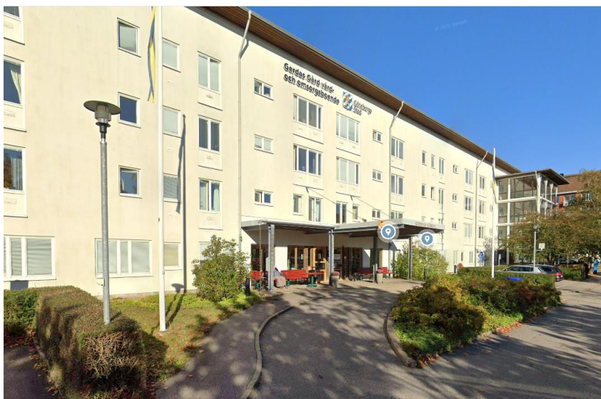
Gerdas gård, Södra fasaden med huvudentré, Google maps.
