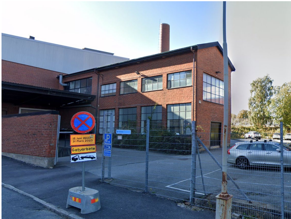
Lantvärnsgatan. Värmecentral inklusive skorsten föreslås bevaras.
