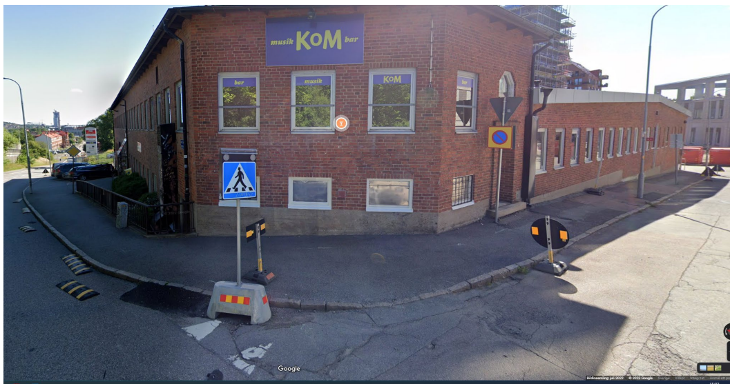
Hörnet mellan Karl Johansgatan och Lantvärnsgatan. Bebyggelse som föreslås rivas.
