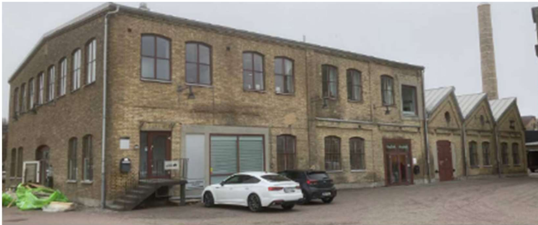
Appreturbyggnaden sedd från öster, med den södra utbyggnaden närmast i bild (WSP)
