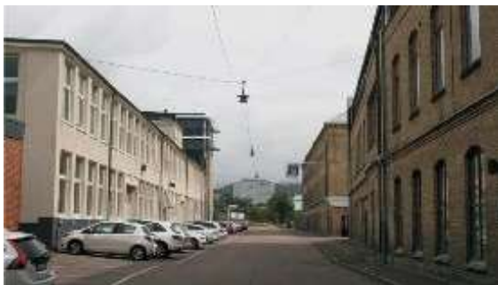
Gamla Almedalsvägen söderut med den gamla syfabriken till vänster i bild och kontoret samt väveriet till höger (Melica)
