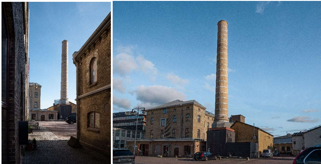
Skorsten och ångpannehus sedda från norr (Liljewall)
