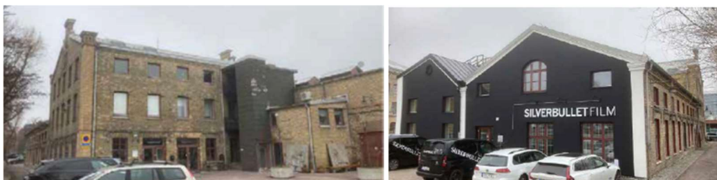
Färgeriet, sett från söder och norr (WSP)
