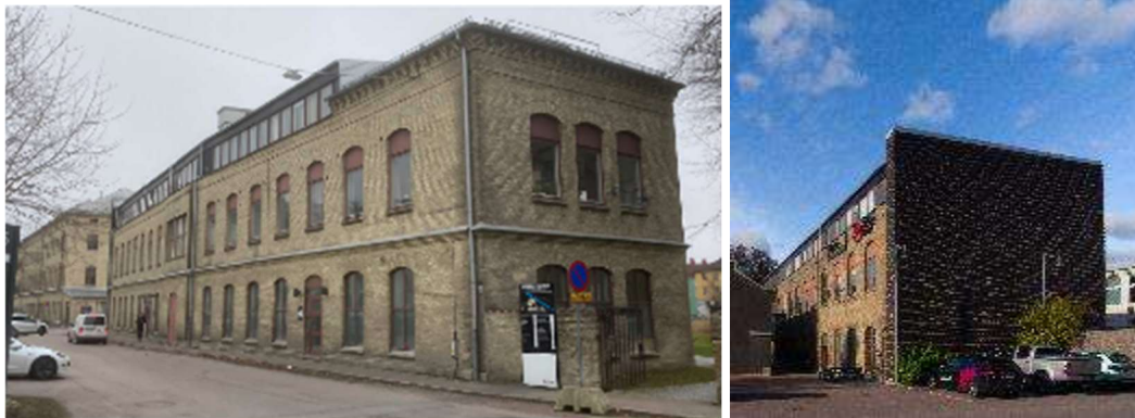
Kontorsbyggnad, fasad mot öster (t.v) och söder (WSP, Stadsbyggnadsförvaltningen)
