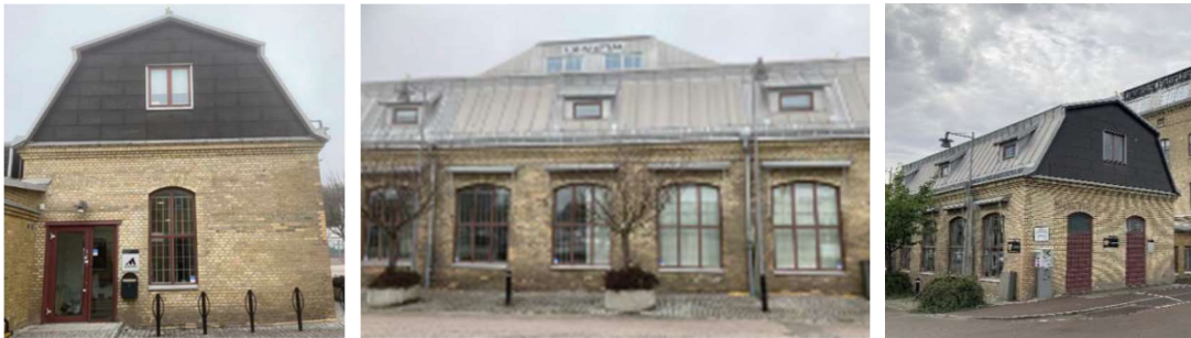
Portvaktshus, fasad mot väster, öster och söder (WSP, Stadsbyggnadsförvaltningen)
