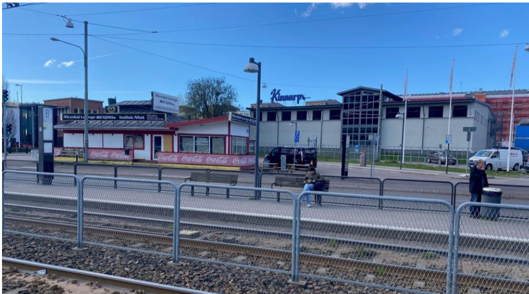
Figur 33: Vy österifrån över vändslingan och kiosken, i bakgrunden befintlig bebyggelse inom Krokslätt 34:18
