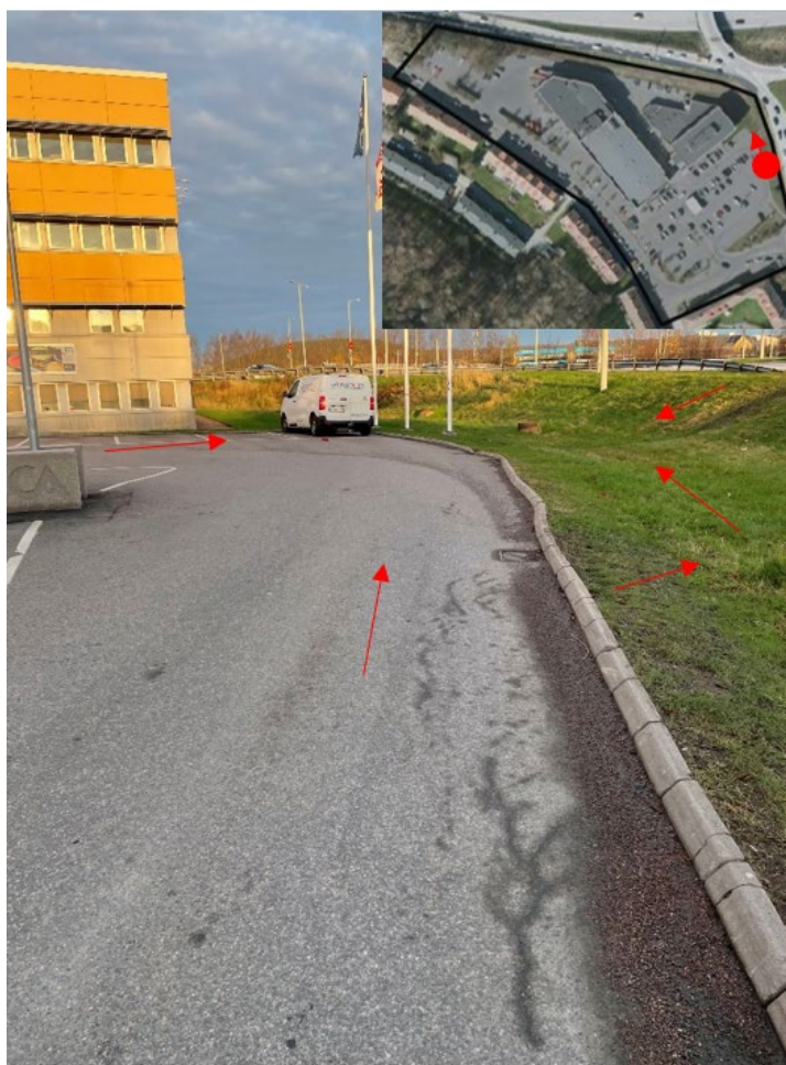
Figur 4. Avvattnings och anslutningspunkt i en lågpunkt, rinnvägar visas med röda pilar (foto från fältbesök 2022).
