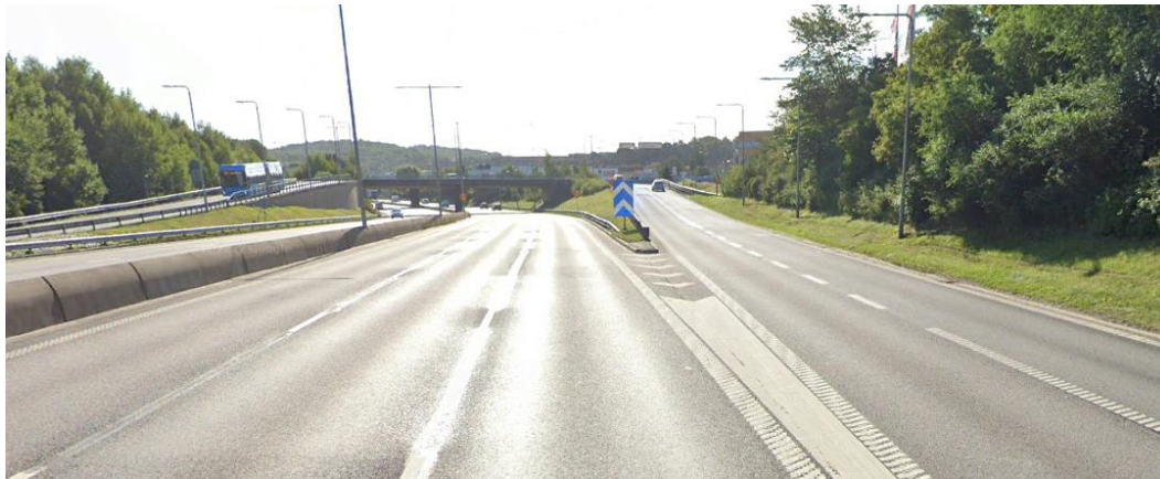
Figur 10. Höjdskillnad mellan E20 och planområdet (längre fram till höger i bild) sett från avfartsrampen.
