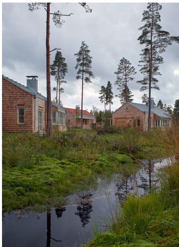
Källsprångsvägen, Viskafors. Exempel på öppen dagvattenlösning. Arkitekt: Brunnberg & Forshed. Foto: Robin Hayes.
