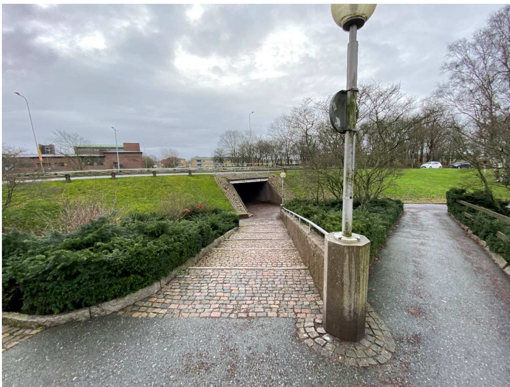
Gång- och cykeltunnel under Smyckegatan och Skattegårdsvägen.
