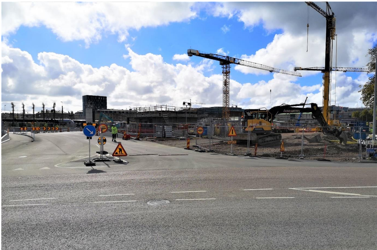
Figur 4. Vy inom planområdet där det idag är byggarbetsplats för Västlänken.
