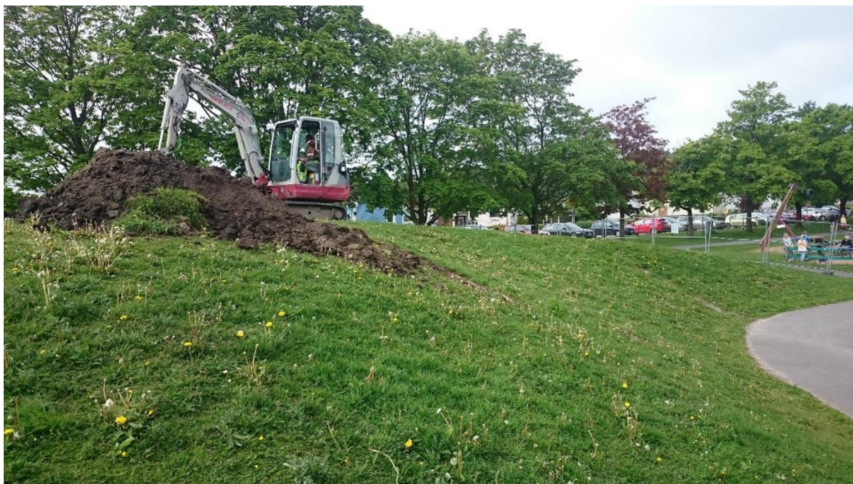
Figur 6. Jordhög med fyllnadsmassor som identifierades som markföroreningar och helt schaktades bort vid Jättstensskolan (149:3). Källa: SWECO, 2015, Rapport – Jättstensskolan – utförda markarbeten inför uppförande av skolpaviljong
