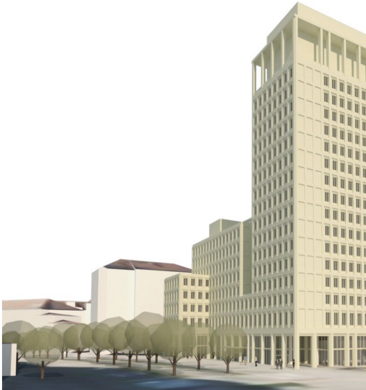
Vy över Bohusgatan sett från Skånegatan i sydost (Kanozi Arkitekter).
