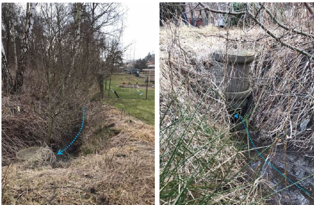
Norra delen av diket. Foto: Kretslopp och vatten.
