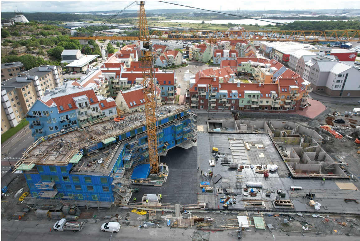
Figur 3: Foto över pågående byggnation inom planområdet (Amhult 2, 2024)
